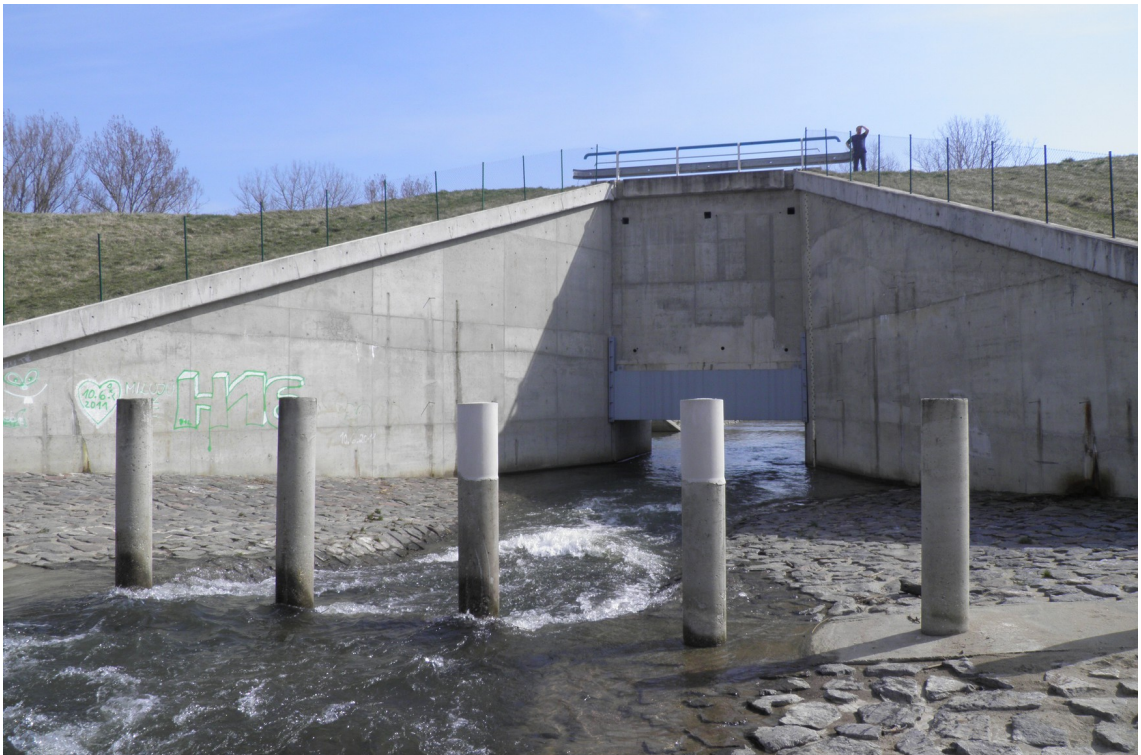
Obr. 23 výpust poldru (foto: Viačková, 2014)
