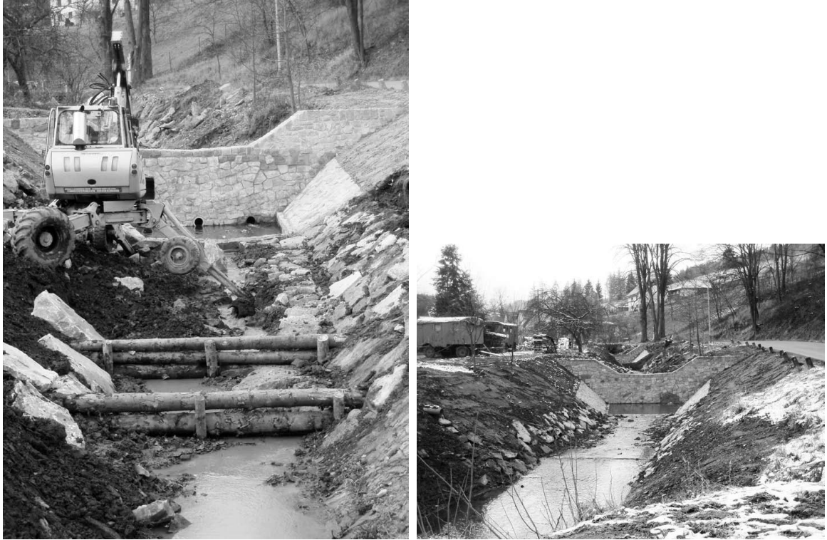
Obr. 41: Budování kamenných stupňů (Zdroj: www.zdechov.cz )
