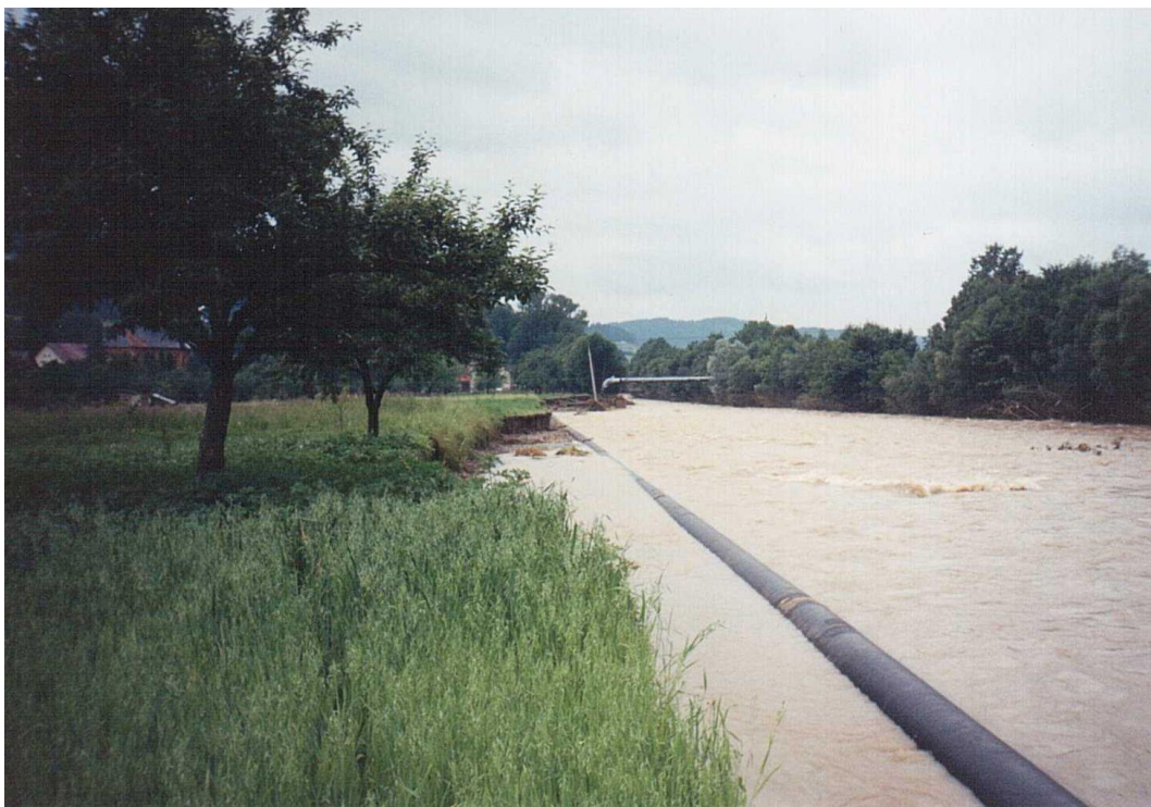
Obr. 31: Obnažený skupinový vodovod Stanovnice při povodni v roce 1997 (Foto: K. Galetka, 1997)
