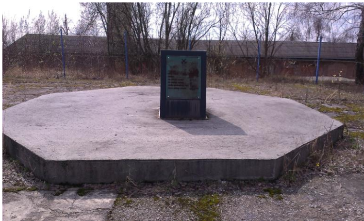
Obr. č. 6 Uzavírací ohlubňový poval Nové jámy (Foto: M. Polášková, 2013)
