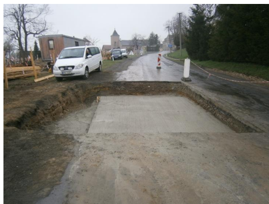
Obr. č. 27 Opravená silnice s betonovou deskou (Foto: Horní Město, 2013)
