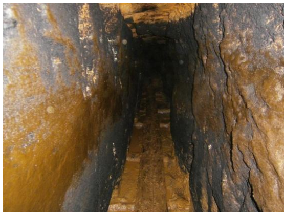
Obr. č. 18 Prostor štoly s podlahou z dřevěných desek
