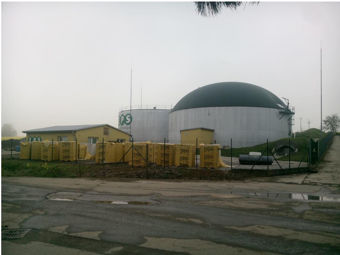
Obr. 10: Bioplynová stanice v Kunovicích (zdroj: vlastní foto)
