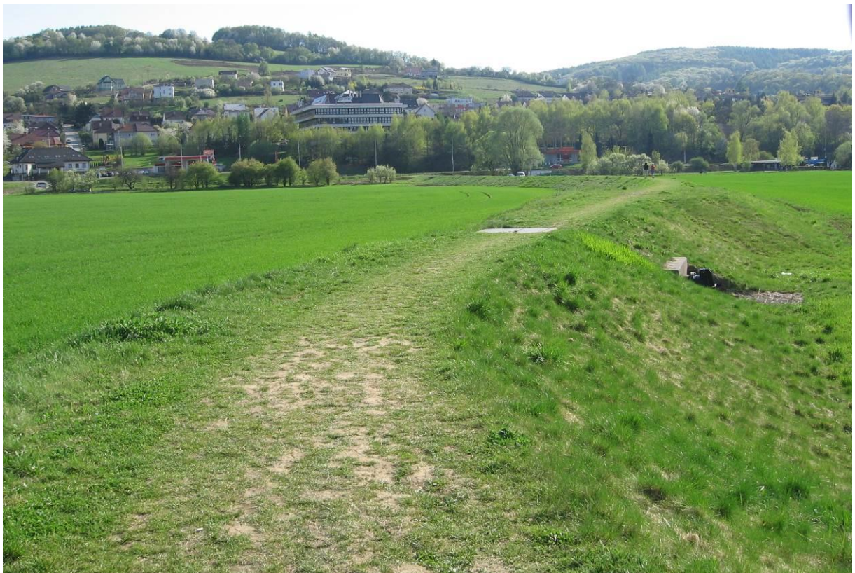
Obr. č. 40: 406 metrů dlouhá zemní hráz na Příkladu (foto: K. Macek, 2013)
