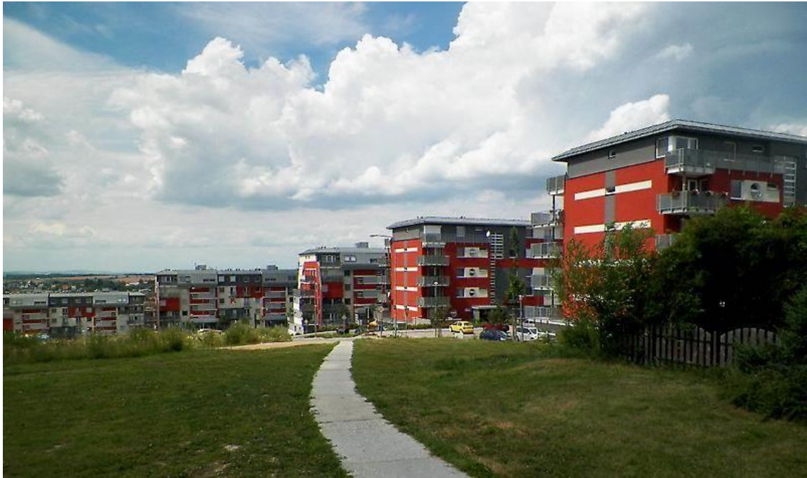
Obr. č. 38: Nový obytný soubor u Centrálního parku Jižních Svahů (foto: autor, 2013)
