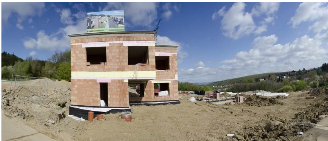
Obr. č. 28: Stavba ze „Zelené residence“ zasazena do terénu, s výhledem na Zlín (zdroj: www.zeleneresidence.cz )
