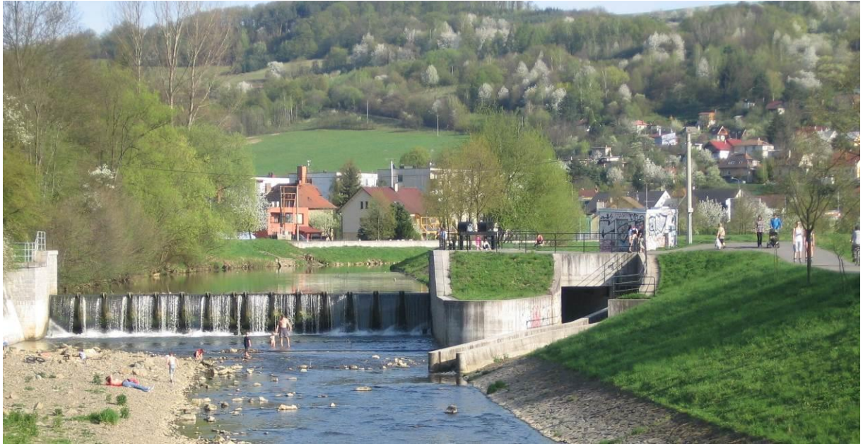
Obr. č. 39: Pohyblivý jez na Příkladu, v pozadí zeď, ohraničující koryto Dřevnice (foto: K. Macek, 2013)
