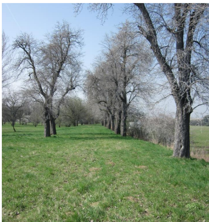
Obrázek č. 11: Hráz mezi historickými rybníky u Přerova
