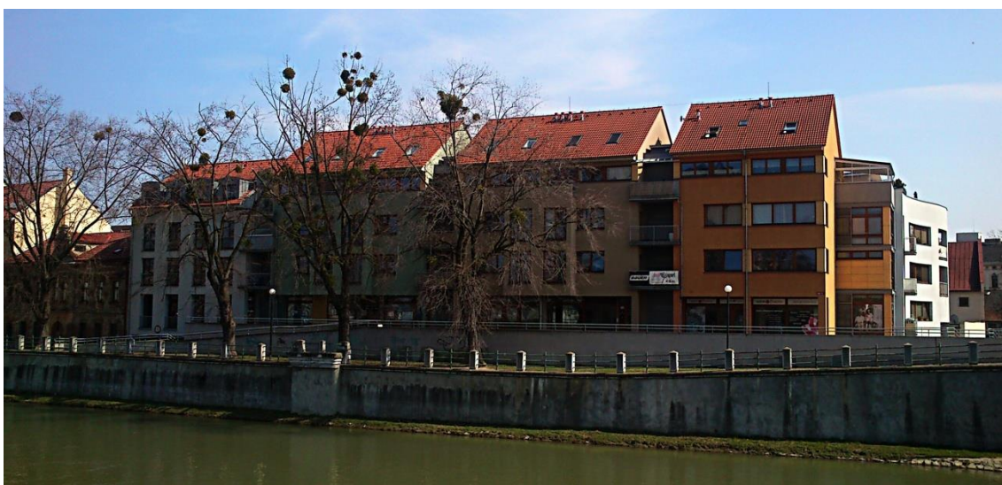
Obr. 9 Zrekonstruované bytové domy na Nábřeží Protifašistických bojovníků, jejichž přízemí je využito službami
