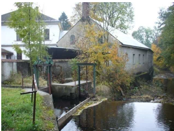
Obr. 13: Náhon k vodní elektrárně pod splavem v Janovicích
