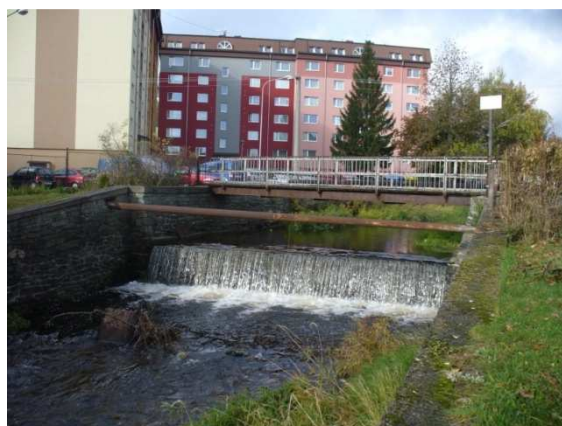
Obr. 16: Upravené koryto z lomového kamene v Rýmařově za ulicí Revoluční
