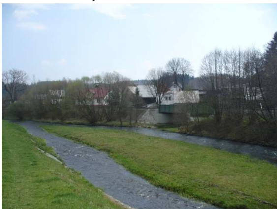
Obr. 15: Stejný pohled ale za mostem
