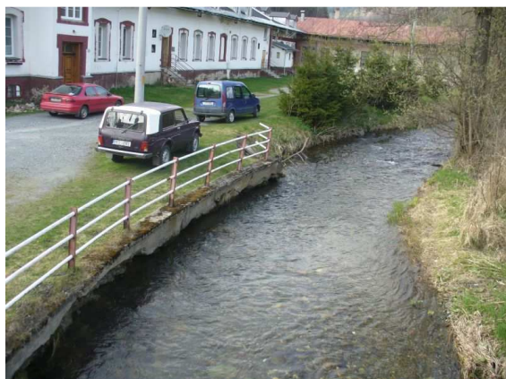
Obr. 1: Nedostatečně upravené koryto a nekapacitní most se záplavovou zónou
