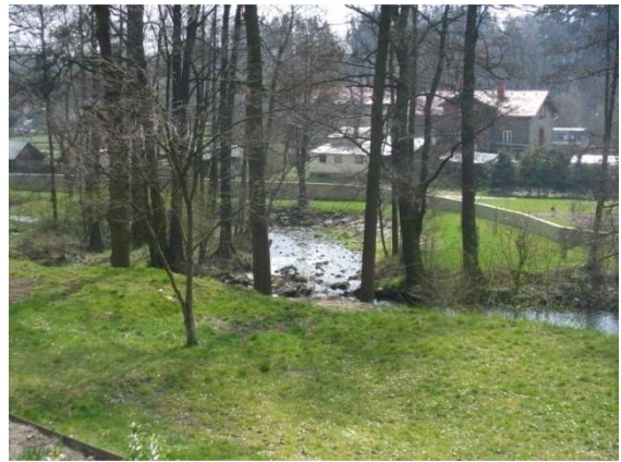
Obr. 8: Koryto řeky s protipovodňovou zdí ve Velké Štáhli
