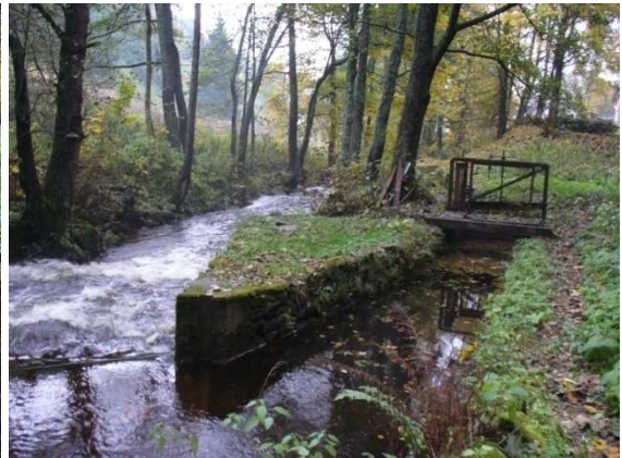
Obr. 6: Náhon k vodní elektrárně ve Staré Vsi
