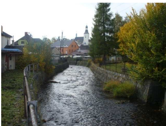
Obr. 15: Upravené koryto z lomového kamene v Rýmařově před ulicí Revoluční
