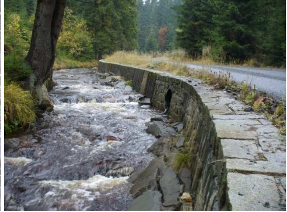
Obr. 2: Nově zpevněný levý břeh pomoci prefabrikátů a lomového kamene
