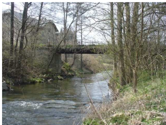
Obr. 16: Most k železniční zastávce Břidličná Lesy
