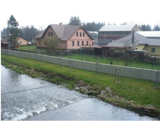
Obr. 7: Pravý břeh s protipovodňovou zdí ve Velké Štáhli
