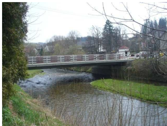
Obr. 14: Most u železniční zastávky Břidličná zastávka
