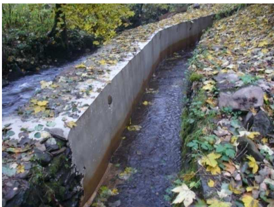
Obr. 7: Zrekonstruovaný vodní náhon
