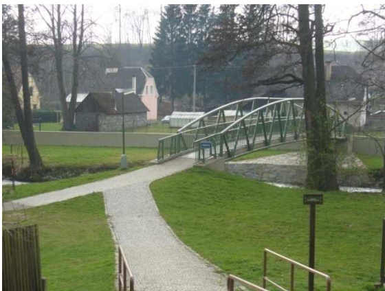
Obr. 9: Nová lávka přes řeku naproti Obecnímu úřadu ve Velké Štáhli
