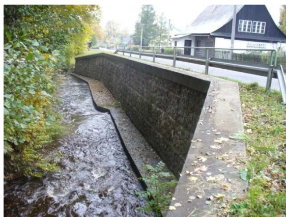
Obr. 10: Upravený pravý břeh kamennou opěrnou zdí ve Staré Vsi
