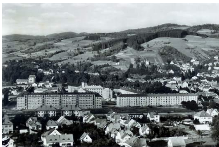
Obr. 30: Typická zděná výstavba koncem 50. let 20. století, nová čtvrť Trávníky, rok 1949.
