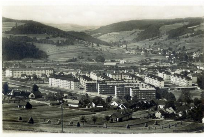
Obr. 28: Pohled na kolonii Z alias Novou čtvrť, vybudována Zbrojovkou Brno pro zaměstnance Zbrojovky Vsetín, rok 1941.
