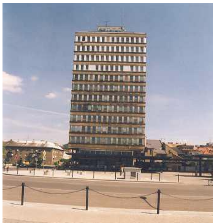
Obr. 38: Věžový dům, další příklad megalomanské socialistické stavby, foto rok 2001.
