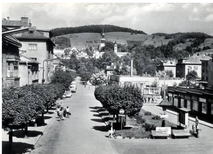
Obr. 32: Žerotínova ulice, rok 1965.
