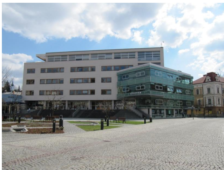
Obr. 40: Asanace objektu OV KSČ ve východní části Dolního náměstí z roku 2001.
