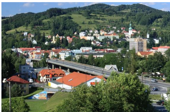
Obr. 18: Štěpánská ulice, fotografie z roku 2009.
