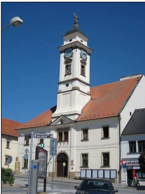
Obr. příl. 33 Městská radnice (zdroj: vlastní snímek, 2013)
