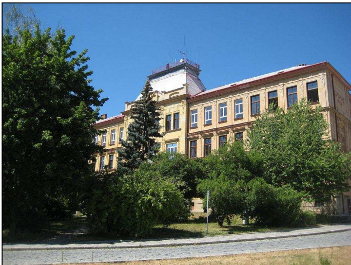
Obr. příl. 31 Pohled na základní školu na Mariánském náměstí v roce 2013 (zdroj: vlastní snímek, 2013)
