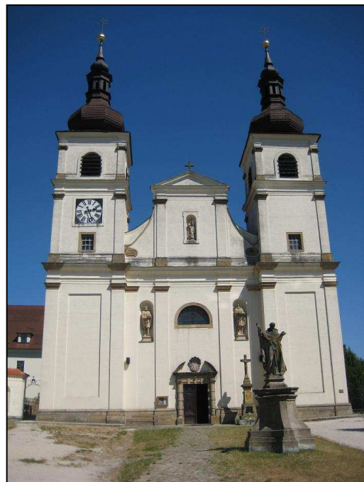
Obr. příl. 32 Kostel Nanebevzetí Panny Marie (zdroj: vlastní snímek, 2013)
