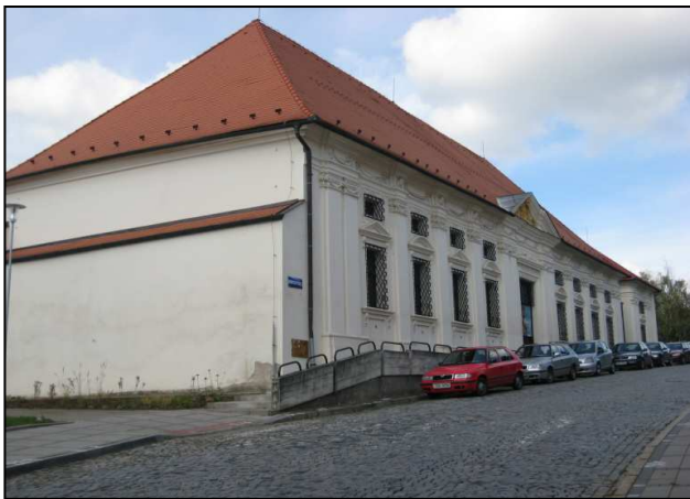
Obr. příl. 7 Budova Baraníku v současnosti (zdroj: vlastní snímek, 2013)
