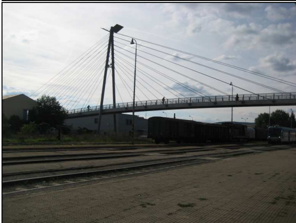
Obr. příl. 43 Dopravní terminál Uherský Brod I. etapa - bezbariérová lávka přes železniční trať (pohled z perónu) (zdroj: vlastní snímek, 2013)
