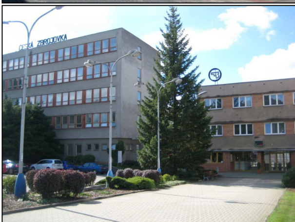
Obr. příl. 41 Vstup do areálu České Zbrojovky (zdroj: vlastní snímek, 2013)
