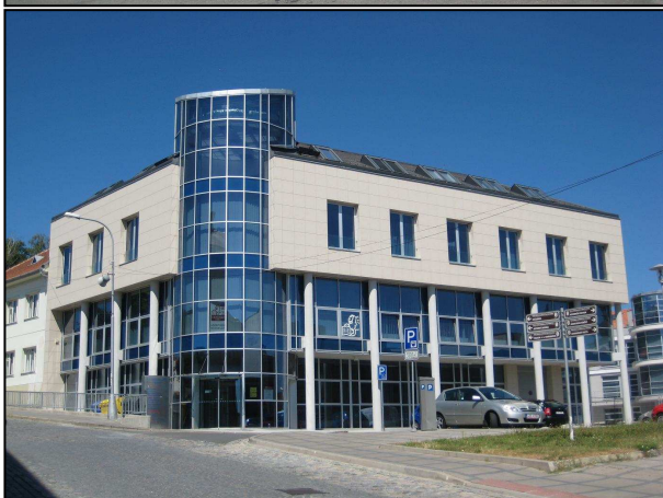
Obr. příl. 40 Moderní výstavba nad Mariánským náměstím - soukromé kanceláře (zdroj: vlastní snímek, 2013)
