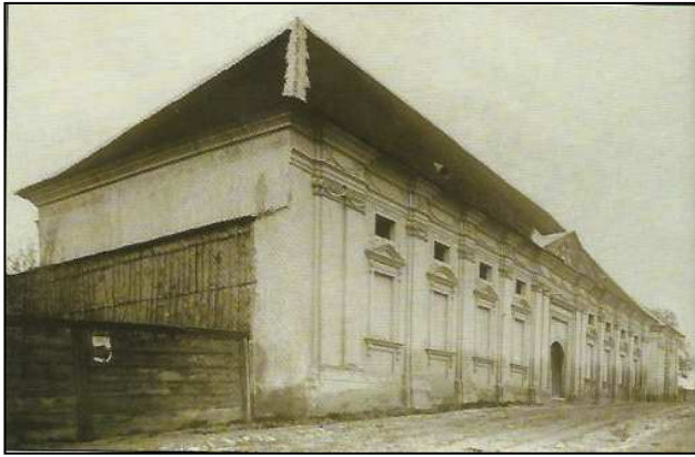
Obr. příl. 6 Budova Baraníku z roku 1906 (zdroj: Tomeček, 2002)
