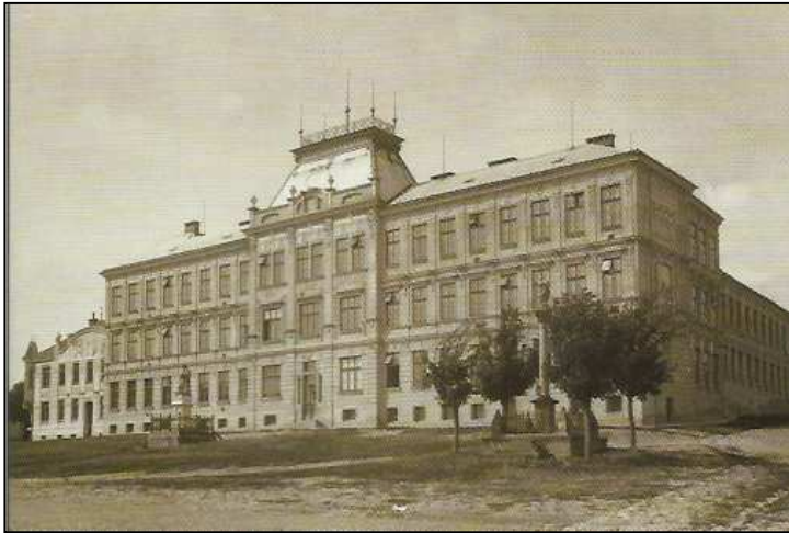
Obr. příl. 30 Pohled na základní školu na Mariánském náměstí v roce 1909 (zdroj: Tomeček, 2002)
