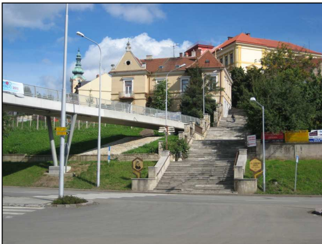
Obr. příl. 27 Velké schody od hlavního nádraží s bezbariérovou lávkou v současnosti (zdroj: vlastní snímek, 2013)
