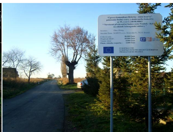
Obr. 27: Nová silnice Rylovka – Krzyżkowice
