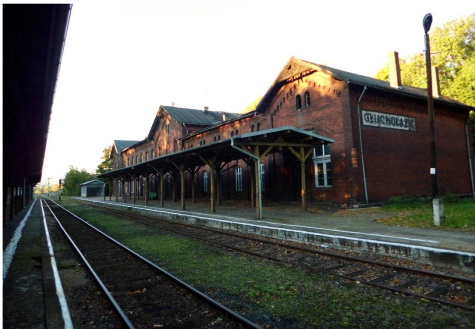
Obr. 44: Železniční stanice Głuchořazy
