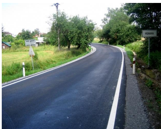
Obr. 26: Silnice II/457 po rekonstrukci
