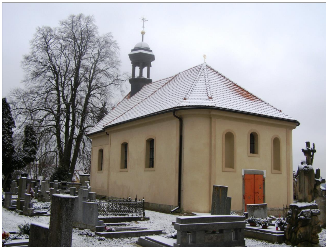
Obr. č. 14: Kostel Nanebevzetí Panny Marie v Kostelci, zima 2014.
