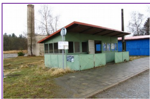
Obr. 77: Pozůstatky architektury 2. poloviny 20. století
