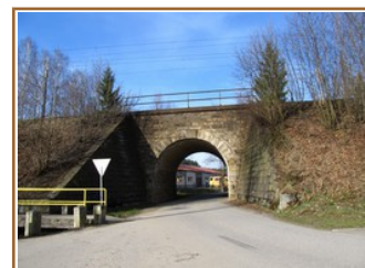
Obr. 21: Dopravní násep a průkop v Hamrech nad Sázavou
