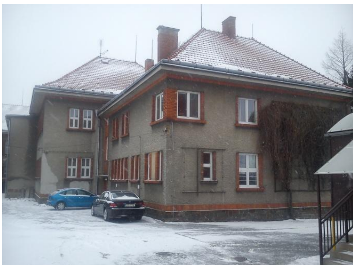
Obr. č. 8: Budova na ul. Komenského 145 (foto Altmanová, březen 2013)
