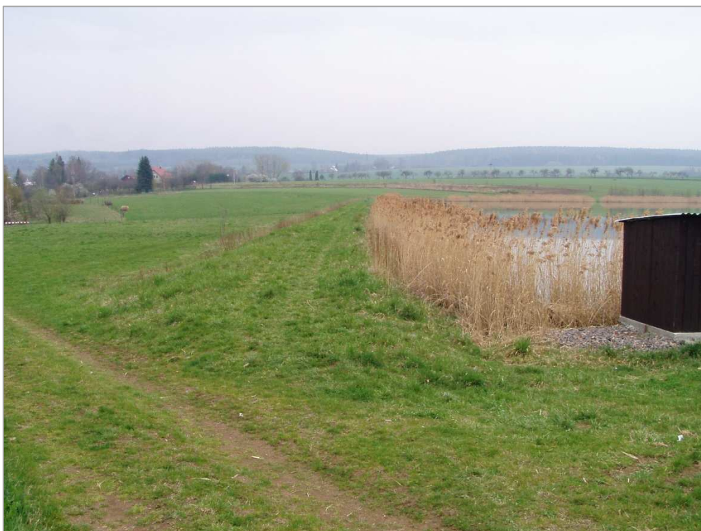
Obr. 5a: Pohled na hráz rybníka Krouna Malá, délka hráze 180 m, výška 1,7 m (P. Adámek, 2014)
