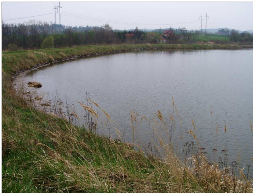
Obr. č. 9: Pohled na hráz obnoveného Pílského rybníka u Krouny (P. Adámek, 2014)
