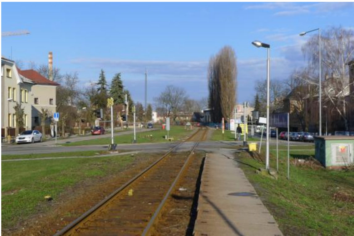
Obr. 46. Okolí železniční stanice Smetanovy Sady, zdroj: archiv autorky
