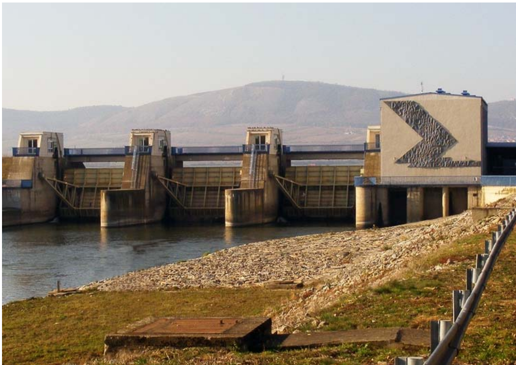
Obr. 8: Výpusť na hrázi Novomlýnské nádrže s vodní elektrárnou, v pozadí Pavlovské vrchy (foto: autorka 12. 11. 2011)
