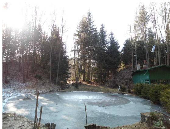
Obr. č. 10 Protržená hráz rybníka Rathanu a nově vzniklé jezírko pod hrází (Šustrová, 2013)
