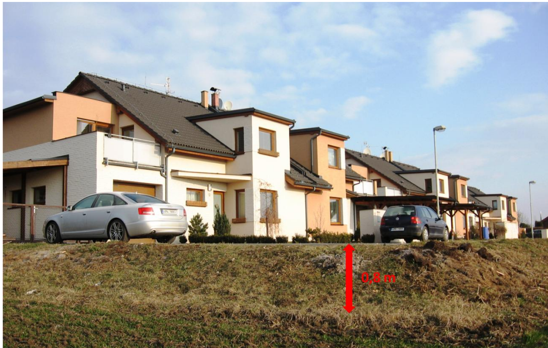
Obr. 15: Vyrovnání terénu pro potřeby výstavby rodinných domů (ul. Dolní Křemelná)
