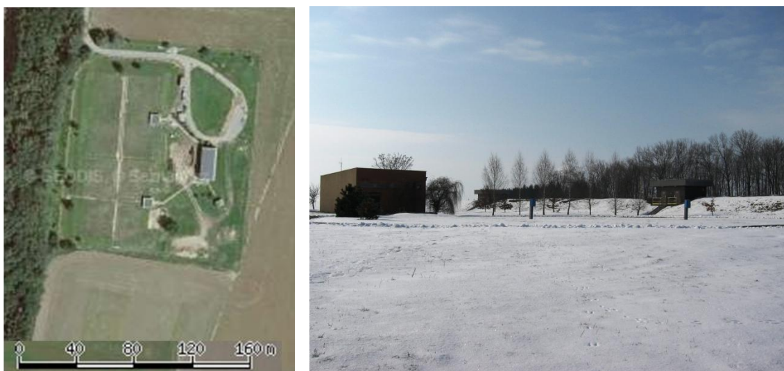
Obr. 17, 18: Vodojem Křelov na Dilovém vrchu Zdroj: www.mapy.cz, Foto: D. Štěpánková, 2013
