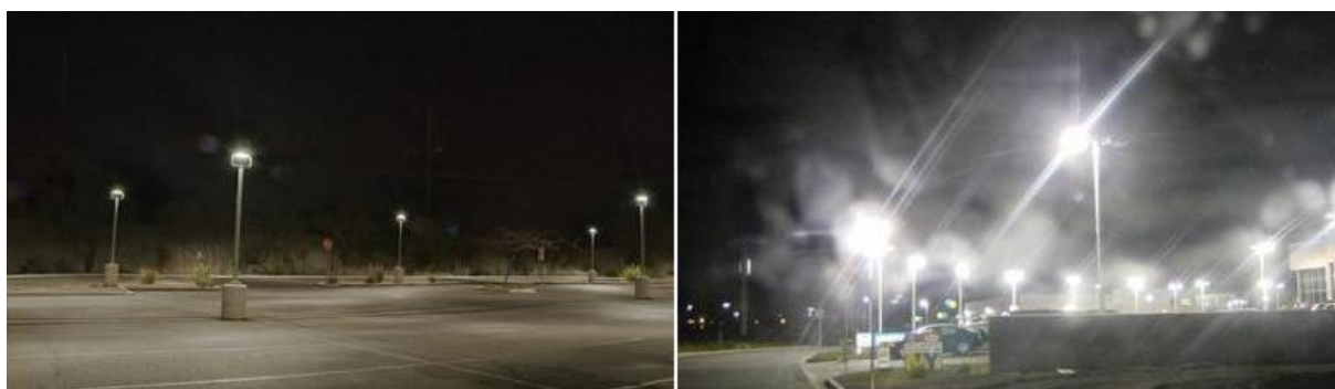
Obr. 16 Cloněné osvětlení zachovávající dostatečnou míru bezpečnosti na parkovišti
