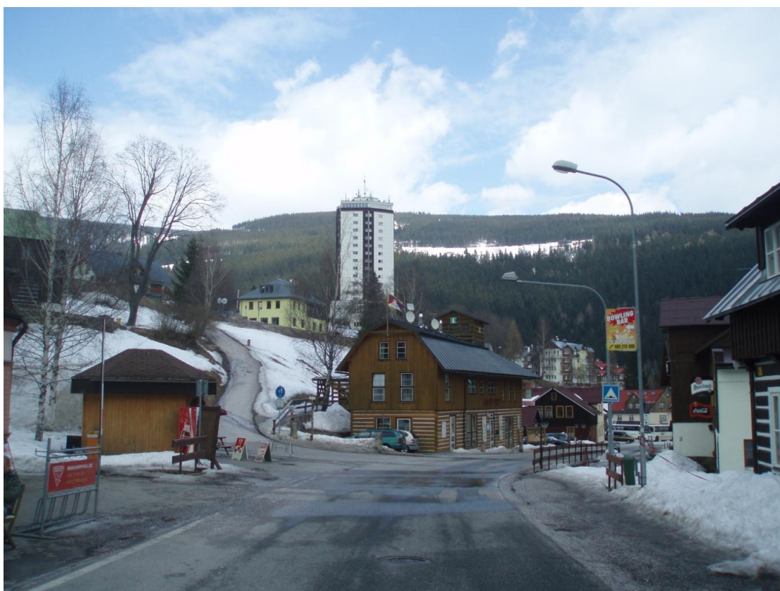
Obrázek 40 Infocentrum Veselý výlet (dřevěná stavba) a hotel Horizont (Zdroj: Eva Součková, 14.4. 2013)
