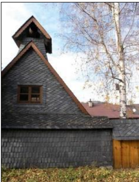
Obr. 37: Střešní krytina z břidlice použité při rekonstrukci budovy (Zdroj: www.bridlicovydullhotka.cz )
