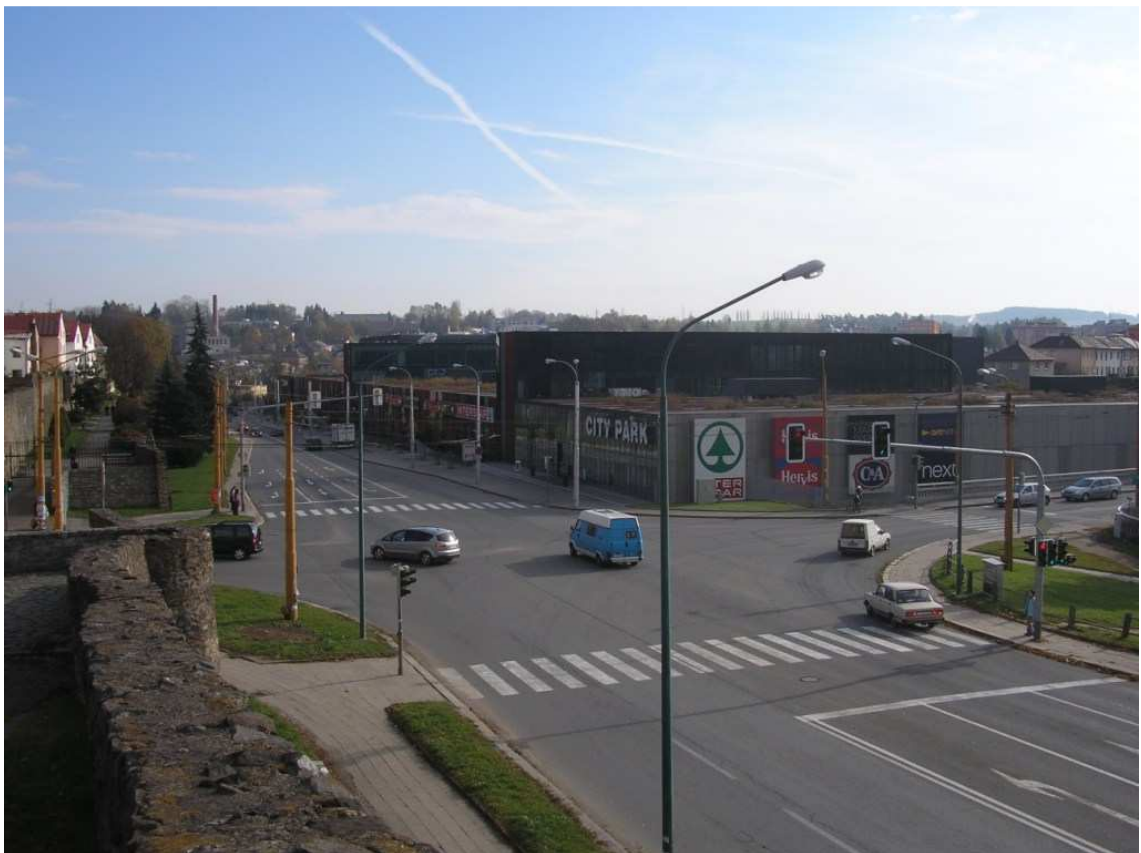
Obr. příl. č. 13 Jedna z nejkontroverznějších staveb po roce 1989 – obchodní centrum City Park v těsné blízkosti historického jádra Zdroj: vlastní foto
