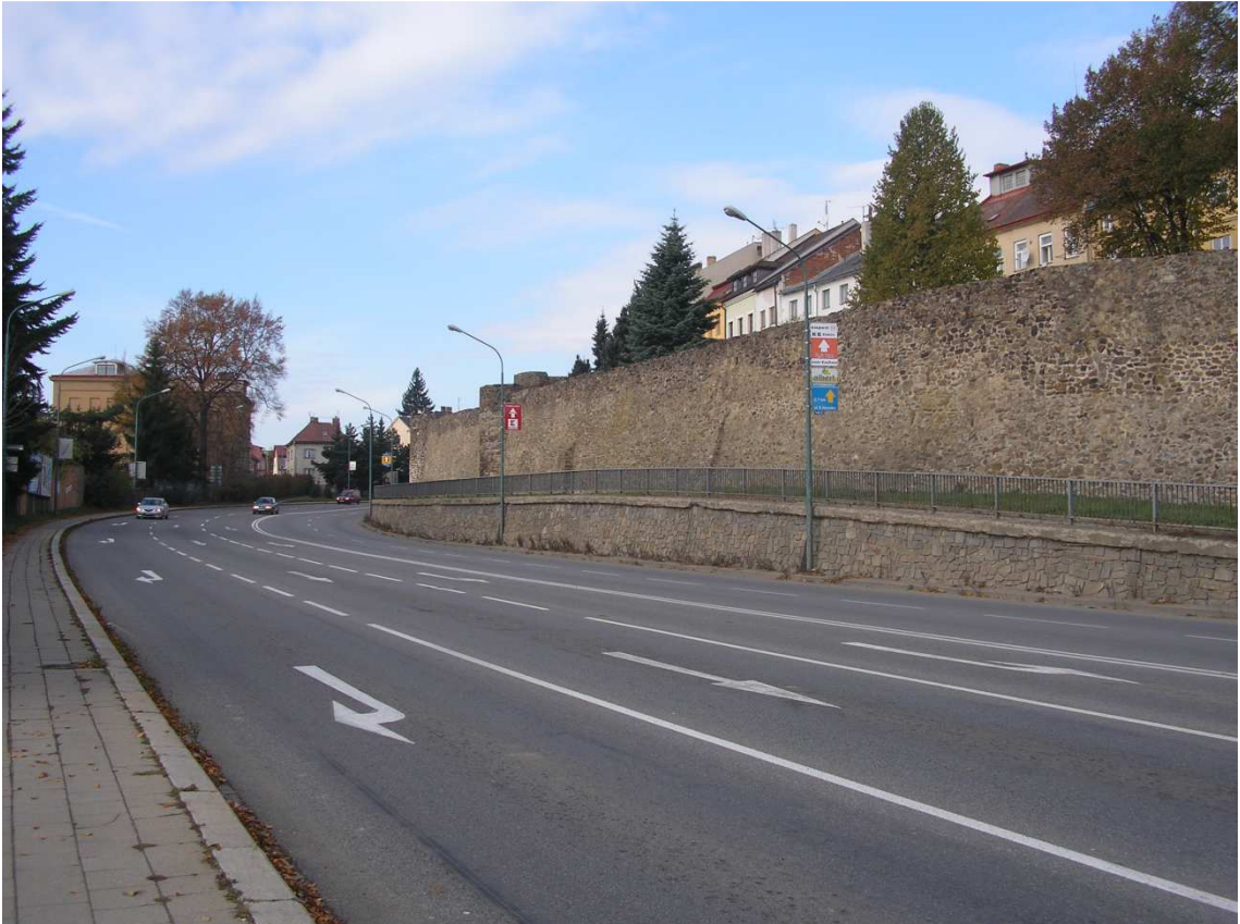
Obr. příl. č. 14 Obvodová komunikace Hradební – hlavní průtah městem Zdroj: vlastní foto
