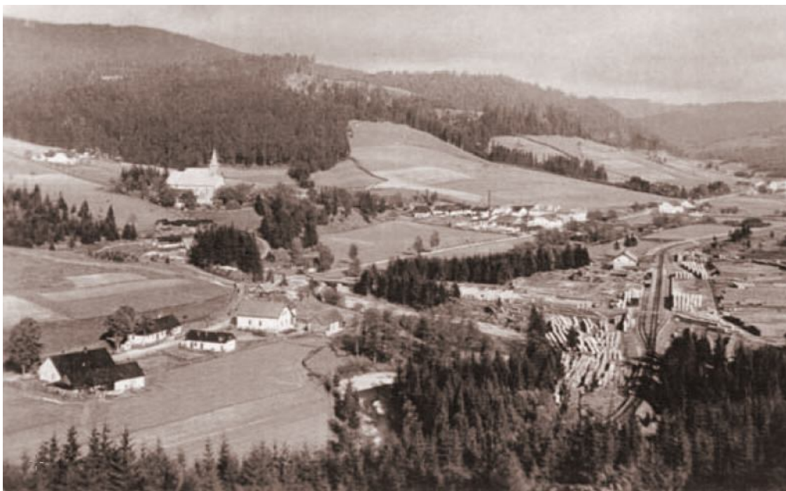
Obr. 3 Centrum obce Staré Hamry před stavbou přehradní nádrže Šance s později zrušenou železniční zastávkou Železnice Ostravice – Staré Hamry - Bílá sloužila v první polovině 20. století hlavně ke svážení vytěženého dřeva z nepřístupných partií hor a nahrazovala i doplňovala vodní cesty, kterými se splavovalo dřevo k dalšímu zpracování Zdroj: Geocaching, 2011
