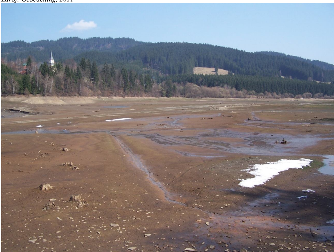
Obr. 4 Vodní nádrž Šance na území bývalého centra obce Staré Hamry (z důvodu opravy a výměny technologií přehradní hráze probíhající od roku 2010, byla vypuštěna část přehrady) Autor: Ilona Lisníková, 2013
