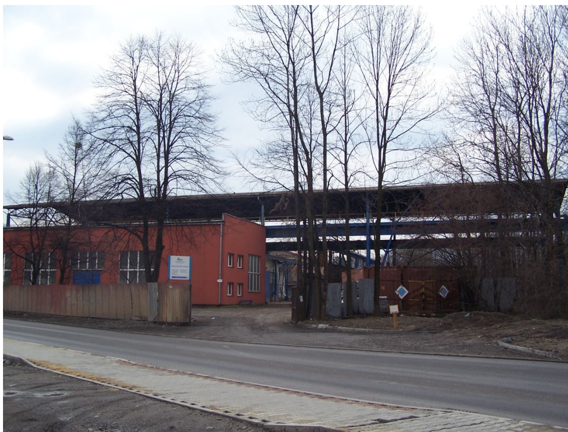
Obr. 7 Bývalý státní podnik Ostroj Opava ve Frýdlantě nad Ostravicí (v současné době slouží areál slévarenskému podniku Giff a.s., zaměstnávající celkem 160 osob a dalším samostatným dílnám)
