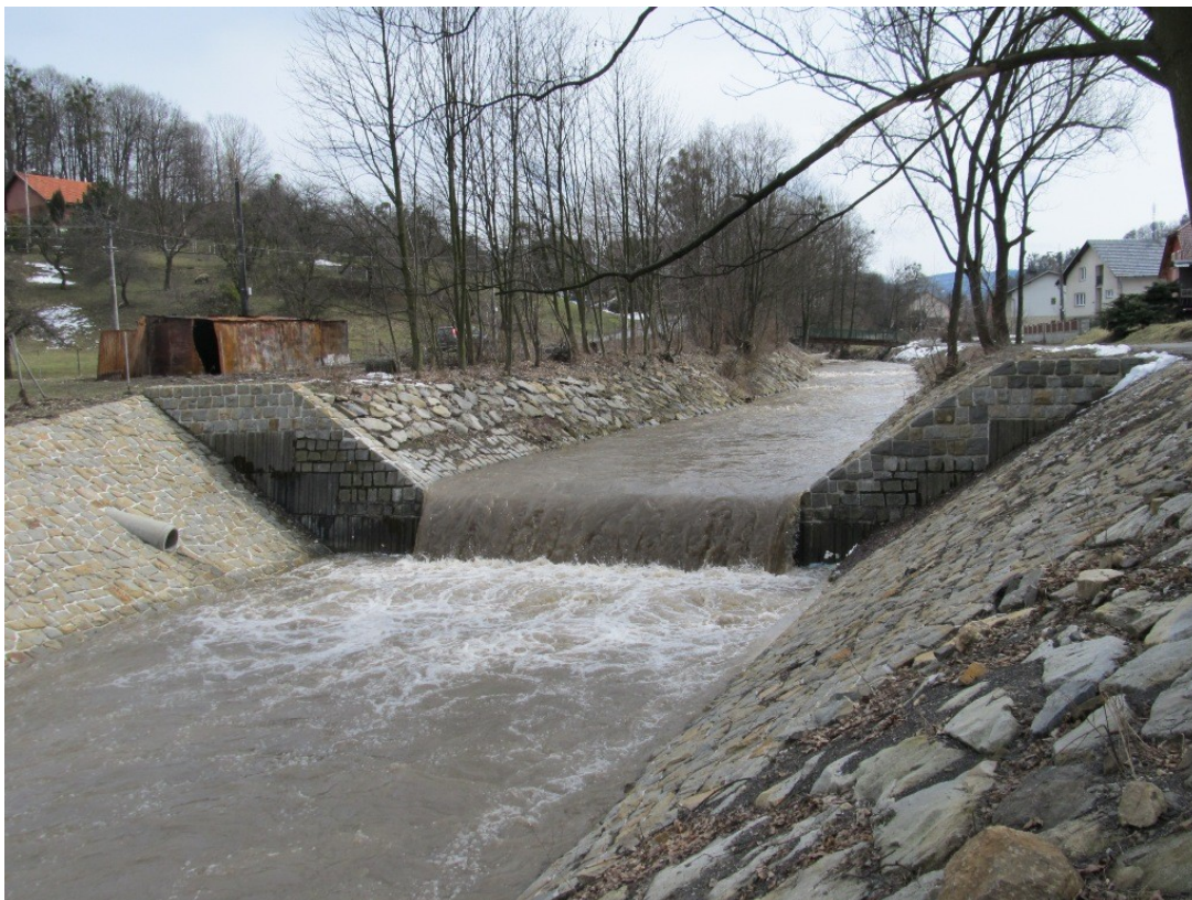
Příloha 21: Nový stupeň v Žilině u Nového Jičína a současná podoba úprav vodního toku v obci. (zdroj: vlastní foto)
