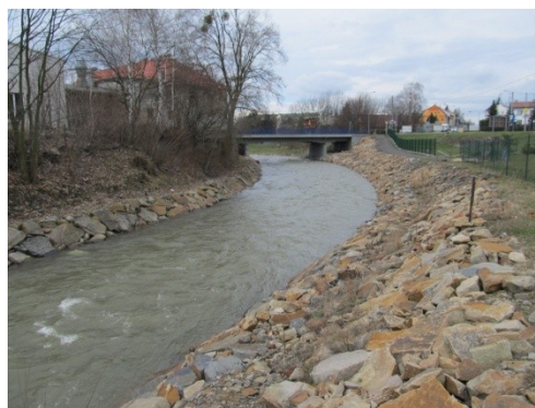
Příloha 23: Stabilizovaný sesuv, způsob úpravy koryta v jeho okolí. (zdroj: vlastní foto)
