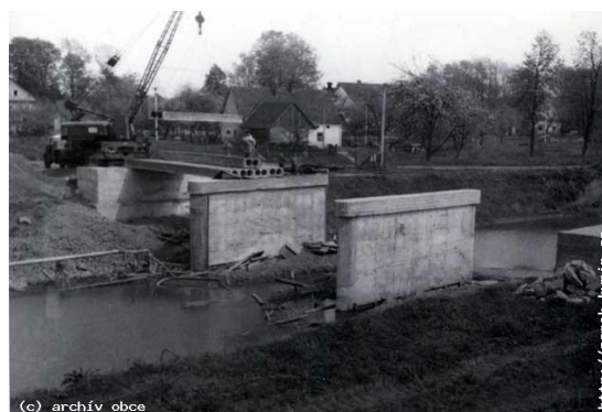
Příloha 10: Jičínka před regulací, stavba mostu přes již regulovaný tok Jičínky. (zdroj: zamek.kunin.cz)
