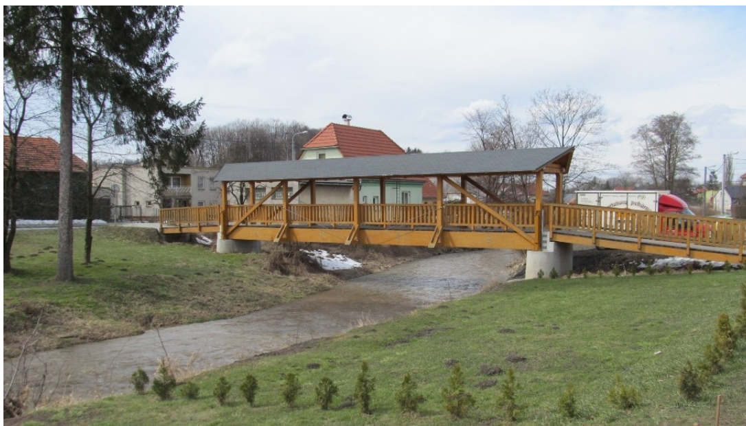
Obr. 16: Nová lávka přes Jičínku v Žilině u Nového Jičína. (Zdroj: vlastní foto)
