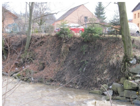
Příloha 20: Levobřežní eroze v blízkosti hlavní komunikace v Žilině u Nového Jičína. (zdroj: vlastní foto)
