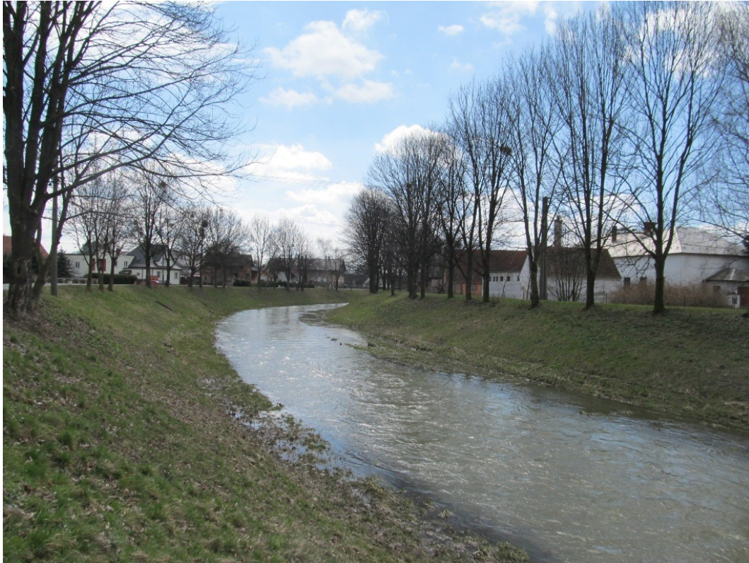
Příloha 24: Způsob úpravy koryta s ochrannými hrázkami osazenými liniovou vegetací v Kuníně. (zdroj: vlastní foto)
