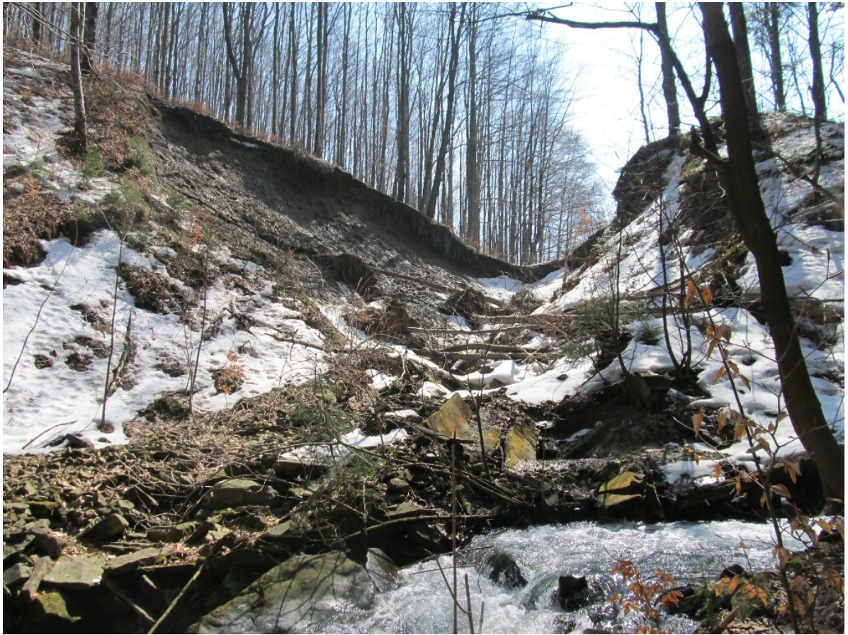
Příloha 15: Celkový pohled na sesuv u splaveninové přehrážky na katastru obce Veřovice. (zdroj: vlastní foto)
