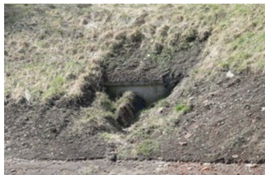
Obr. 19: Zanesená zpětná klapka
