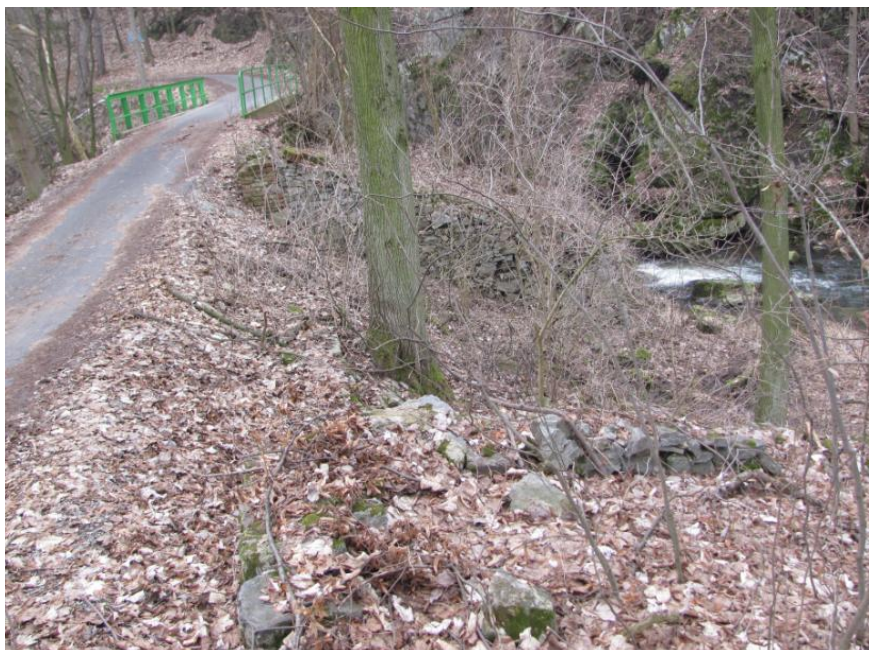
Příl. 11: Rybník u Horního Újezdu, zbytky výpusti.
