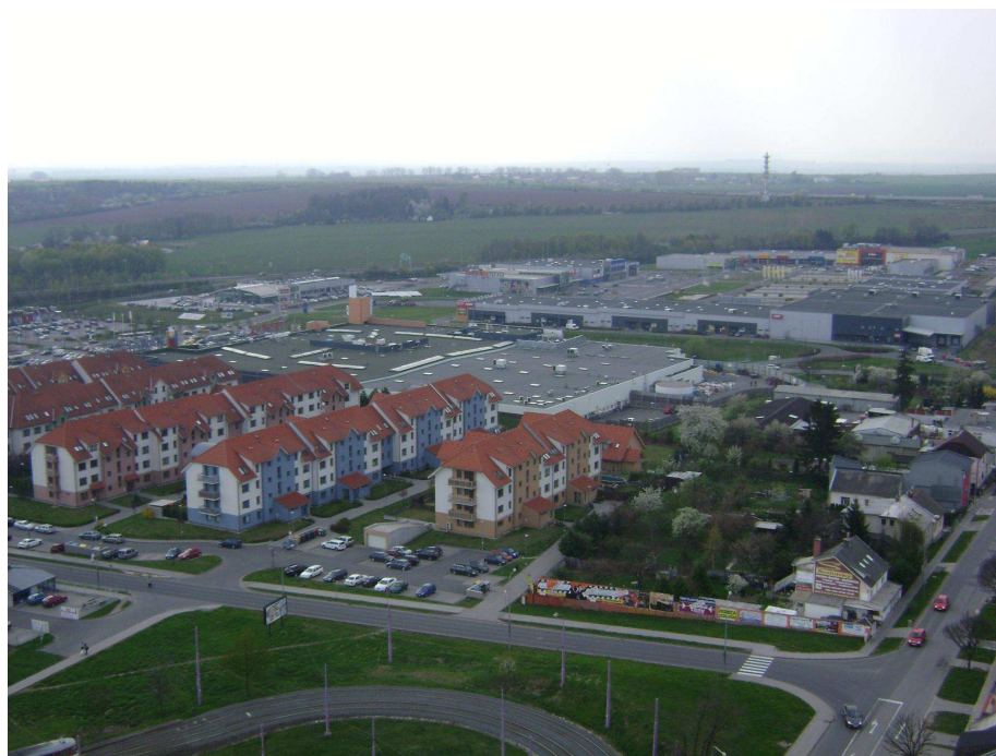
Obr. 11: Vodojem - nákupní centrum Haná (foto: Barbora Dosoudilová, 2011)
