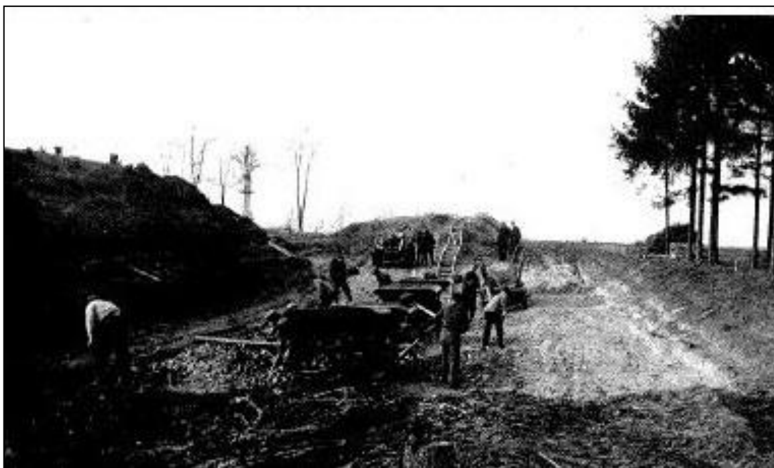
Obr. 50: Budování vodojemu na Stráži – listopad 1949, výkop I. nádrže (externí materiál Veolia, 2013)
