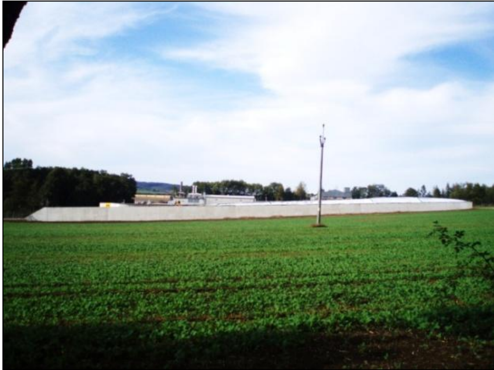
Příloha 22: Oblast bývalé cihelny a stávající areál firmy ECO Finance Group s.r.o. V popředí je vidět betonový žlab pro skladování kukuřičné siláže, za ním pak bioplynová stanice (BORECKÁ, 2012)
