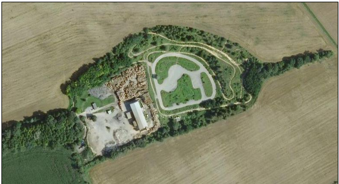
Příloha 23: Letecký pohled na areál firmy ECO Finance Group s.r.o. (Google, 2013)
