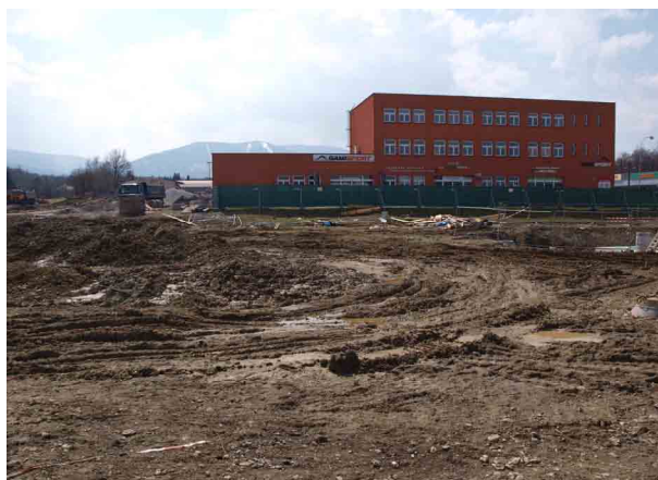
Obrázek 10 Revitalizovaný brownfield Frýdecká, Třinec
