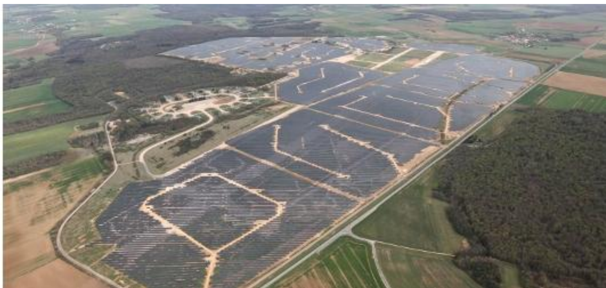
Obr. 25 Největší fotovoltaická elektrárna ve Francii Toul Rosieres (se špičkovým výkonem 115 MW), která byla uvedena do provozu v srpnu roku 2012
