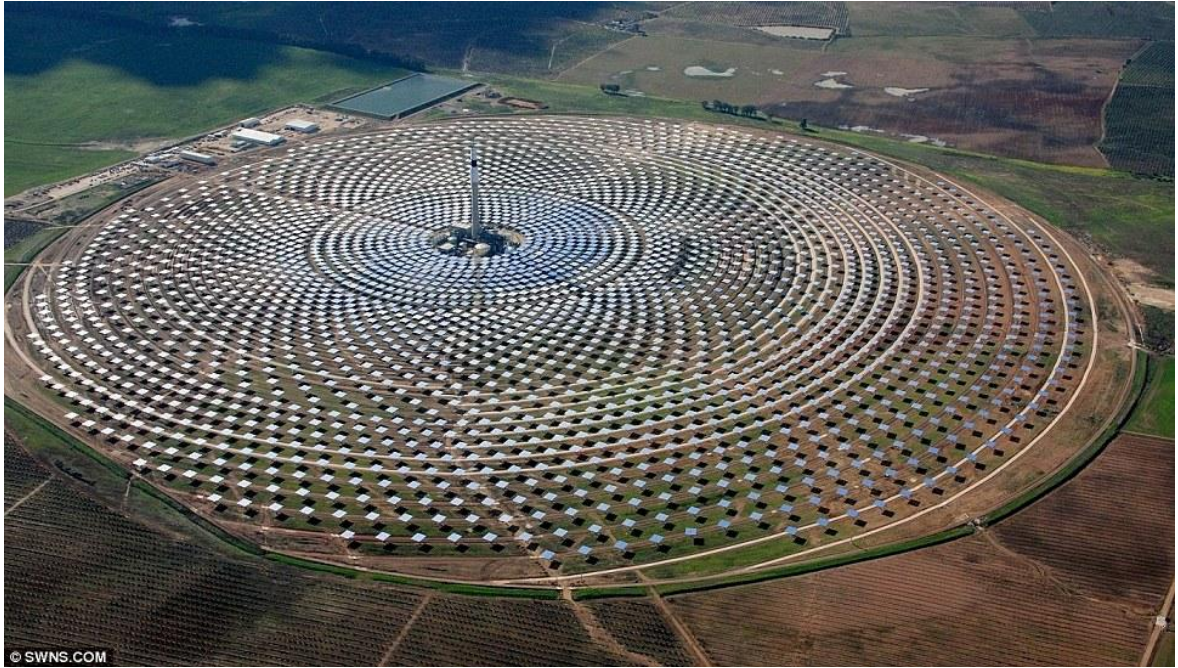
Obr. 4 Příkladem sluneční elektrárny se soustředěním sluneční energie do centrální solární věže je SE GEMASOLAR, Fuentes de Andalucía, Španělsko.
