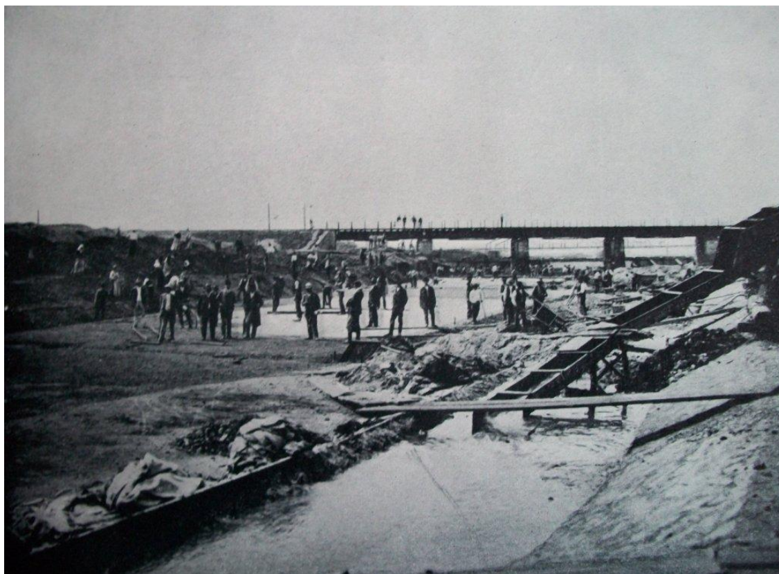
Obr. 8 Betonáž říčního dna pod železničním mostem v Citicích
