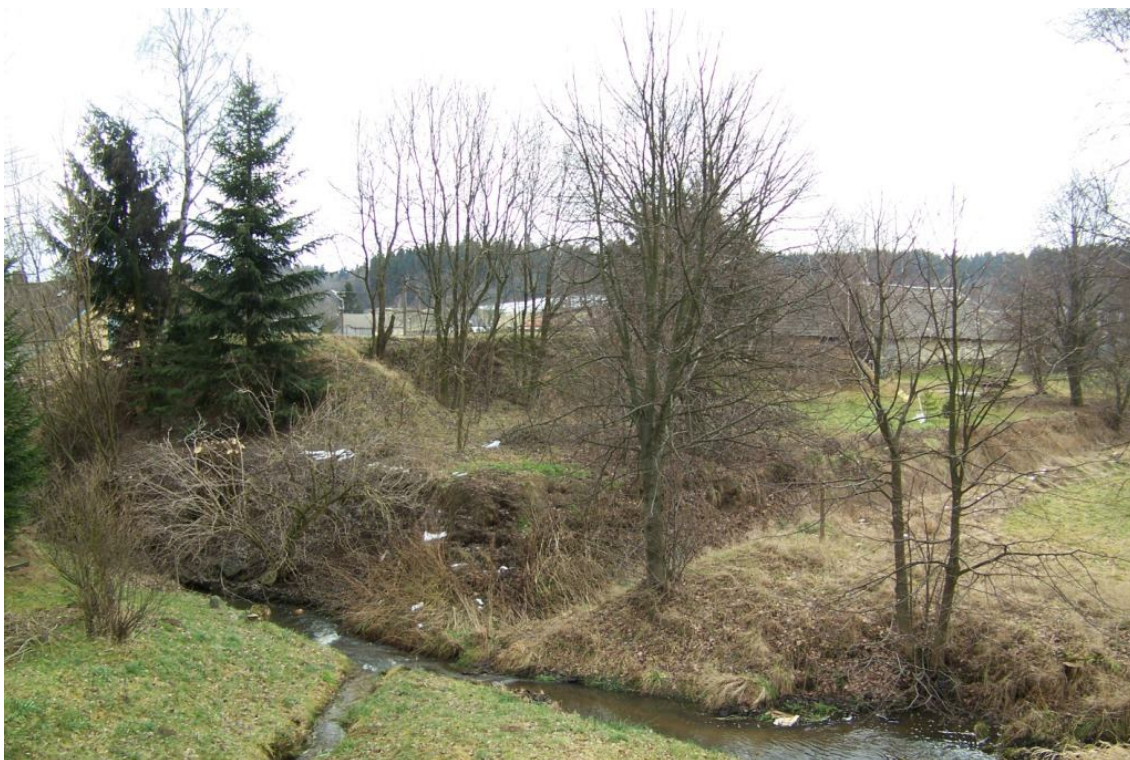
Obr. č. 59: Relikt hráze Soudního rybníka v obci Jedlová (foto: Petra Nastoupilová, 4. 1. 2013)
