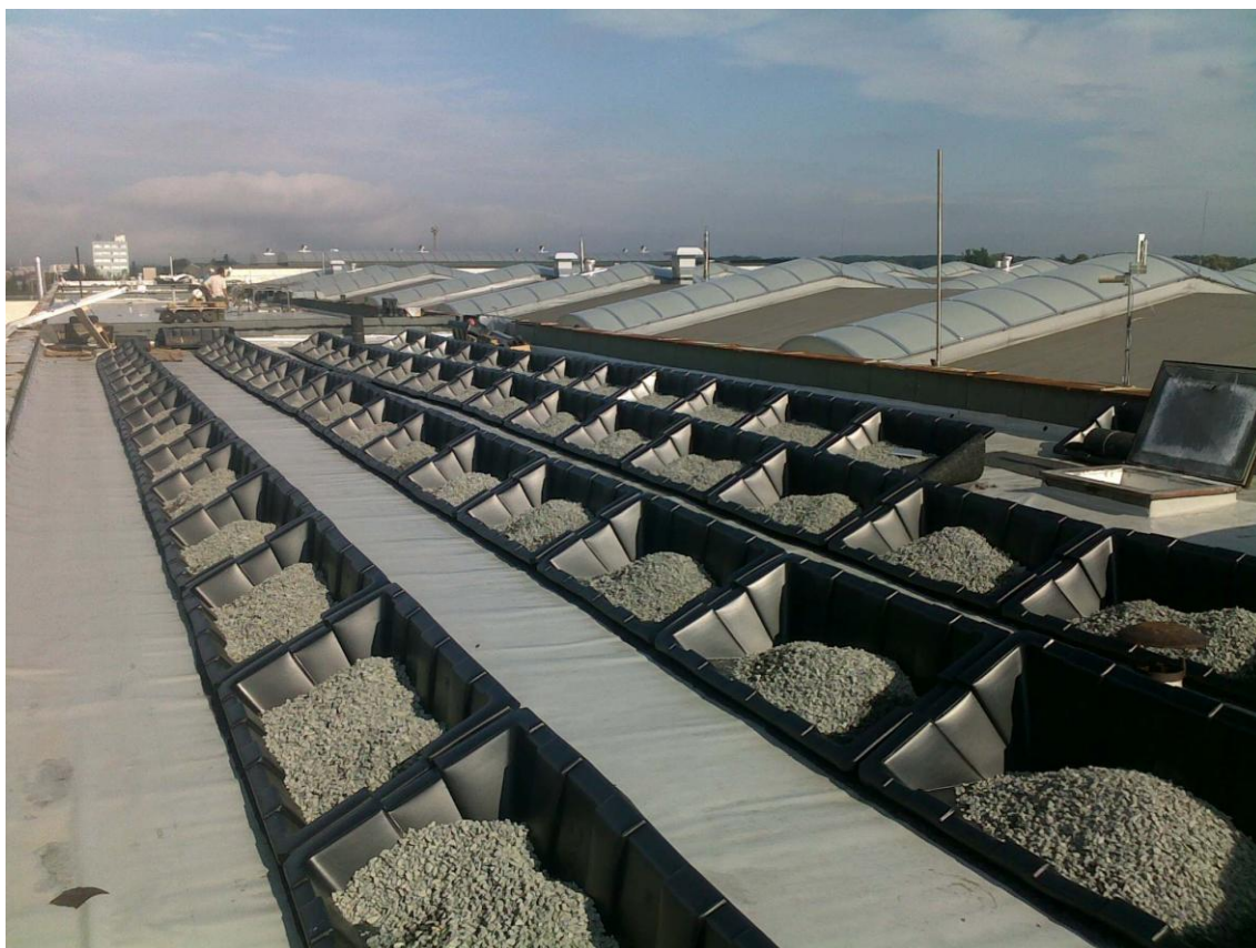
Příloha 9: Výstavba FVE Chválkovice na střeše, archiv CHS Solar Source a.s.
