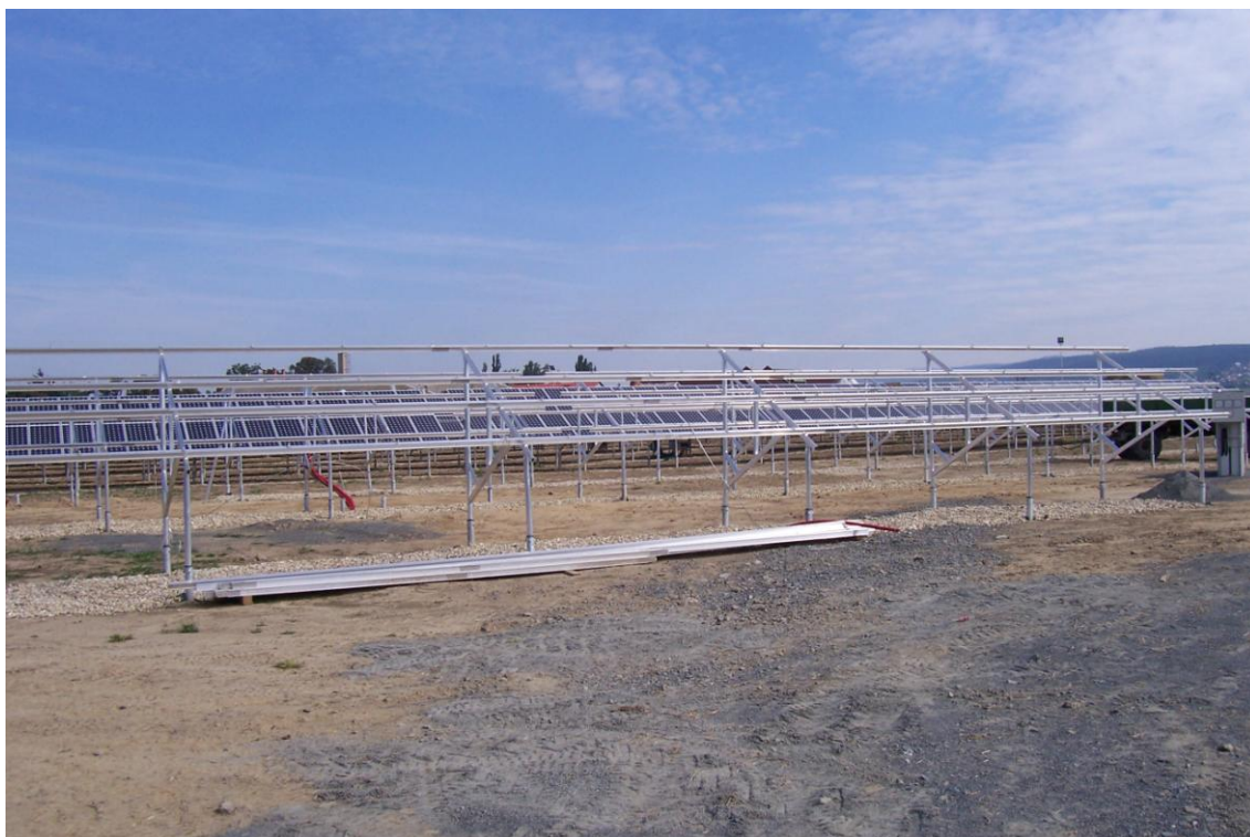
Příloha 3: Výstavba FVE Chválkovice na poli, archiv CHS Solar Source a.s.
