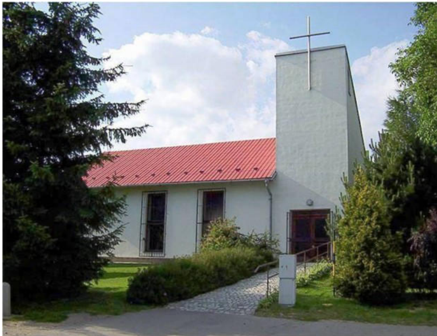
Obr. 19 Kostel sv. Antonína Paduánského v Bukovanech
