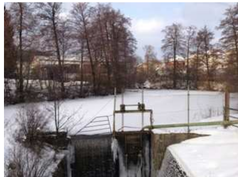
Obr. 30 vodní nádrž na Lukšínce (Bor, 01/2013)
