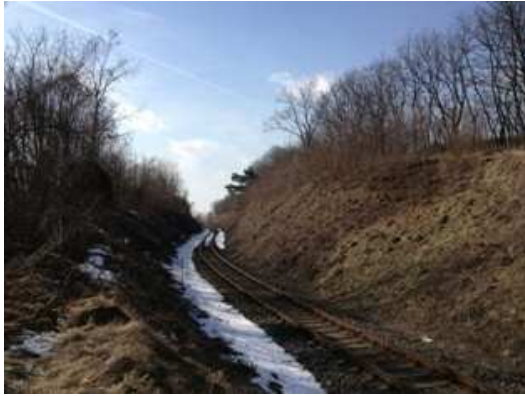
Obr. 21 dopravní průkop v oblasti pitínské smyčky (Bor, 03/2013)
