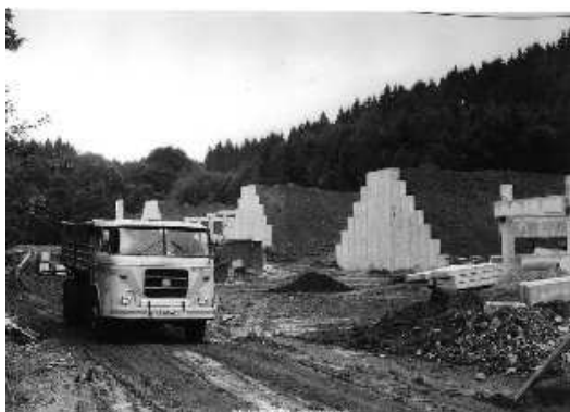
Obr. 13 stavba ochranných valů (zdroj: TV Slepíčín)
