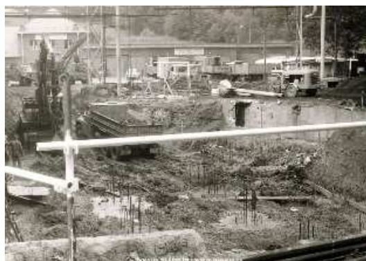
Obr. 3 stavba areálu (zdroj: TV Slepíčín)
