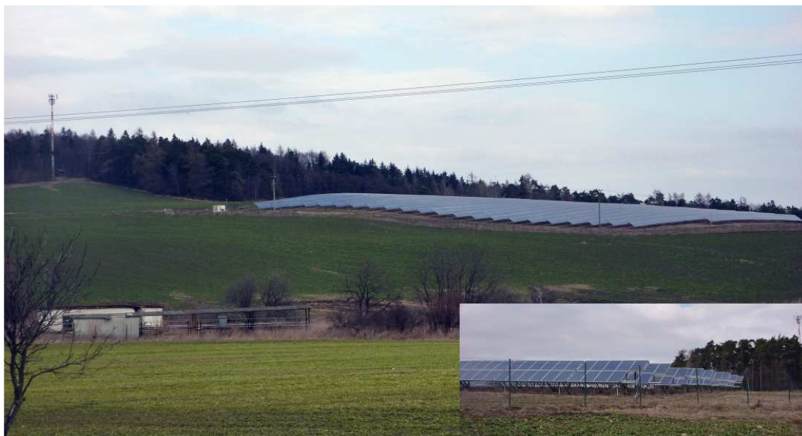
Obr. 20 Fotovoltaická elektrárna Všetice Foto: P. Schill, 2012
