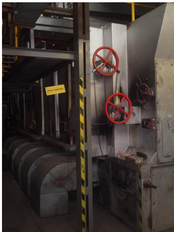
Obr. 32: Kotel K1 – Část, na které bude probíhat modernizace. (Foto: Autor, 2012)
