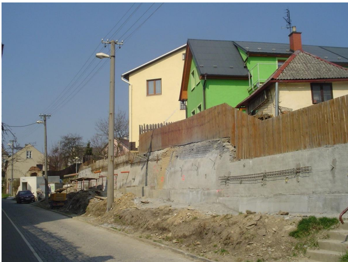
Obr. 43: Průběh prací na sanaci svahu. Foto: Mgr. Kostrůnek, 2009
