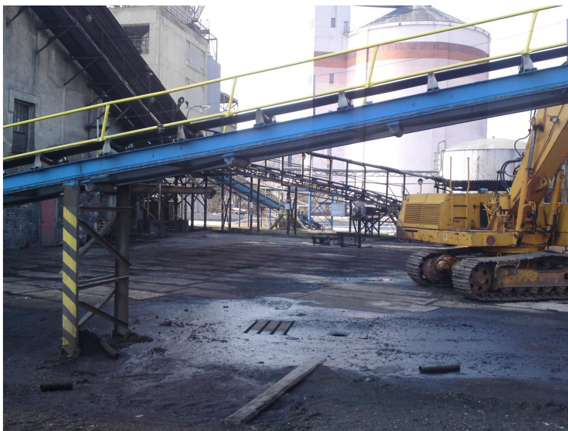
Obr. 33: Prostor skladování paliv a systém dopravníků před rekonstrukcí. (Foto: Autor, 2012)
