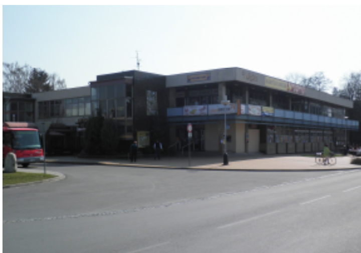
Obr. č. 18: Nákupní středisko na místě bývalé autobusové čekárny (zdroj: Tomáš Körner)
