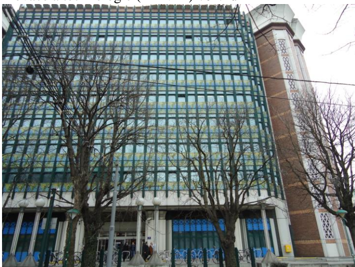
Foto č. 3: budova Spolkového ministerstva pro dopravu, inovace a technologie (BMVIT) ve Vídni
