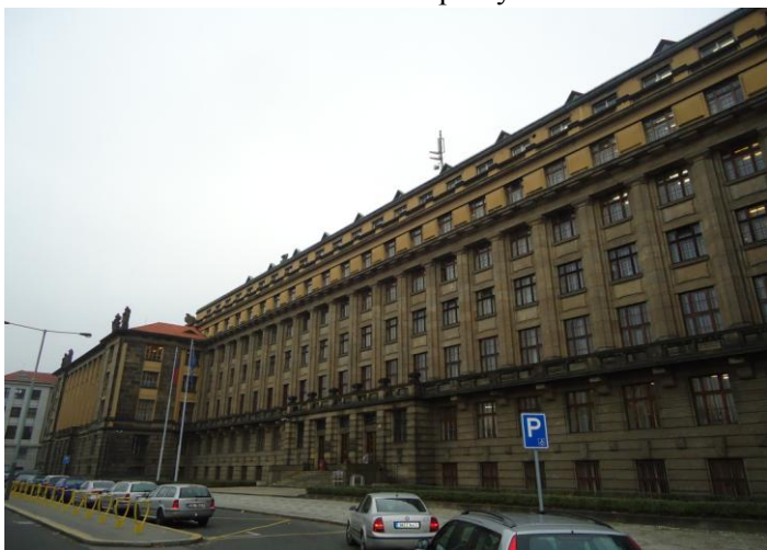
Foto č.1 : budova Ministerstva dopravy ČR v Praze
