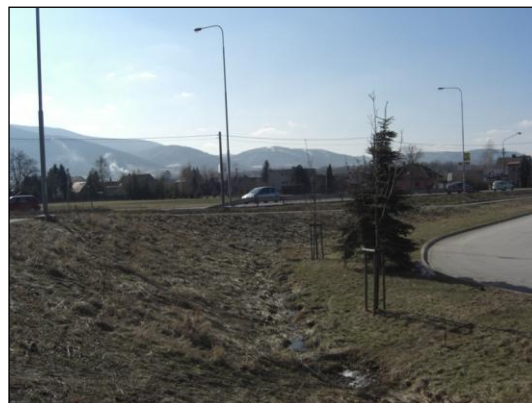
Obr. 38 Akumulace vody v prostoru obchodní zóny okružní křižovatky I/11 s II/476
