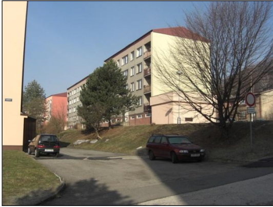
Obr. 33 Sídlní terasa v lokalitě sídliště Sosna Foto: M. Bobková (3/2012)
