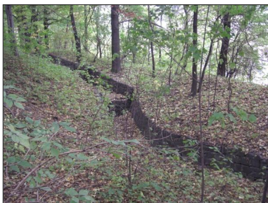
Obr. 4 Odvodňovací příkop u nádraží v Třinci
