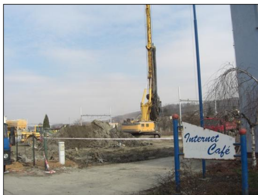
obr. 54 Zemní práce související s realizací mimoúrovňového přejezdu Via Lyžbice
