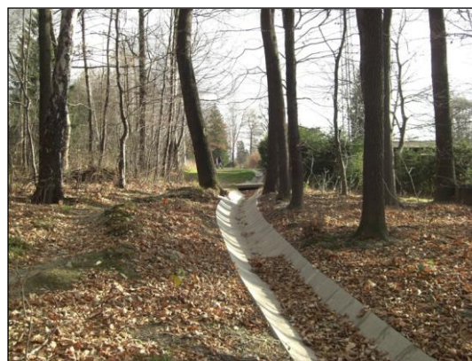
Obr. 40 Odvodňovací příkop v Dolní Lištné
