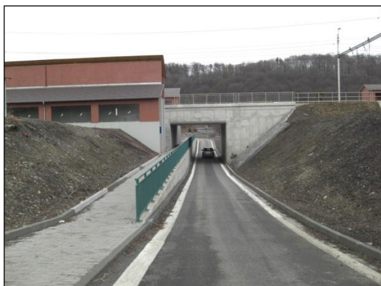
Obr.53 Mimoúrovňový přejezd a násyp v lokalitě Ropice
