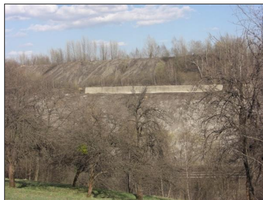
Obr. 24 Zabezpečení západního svahu haldy
