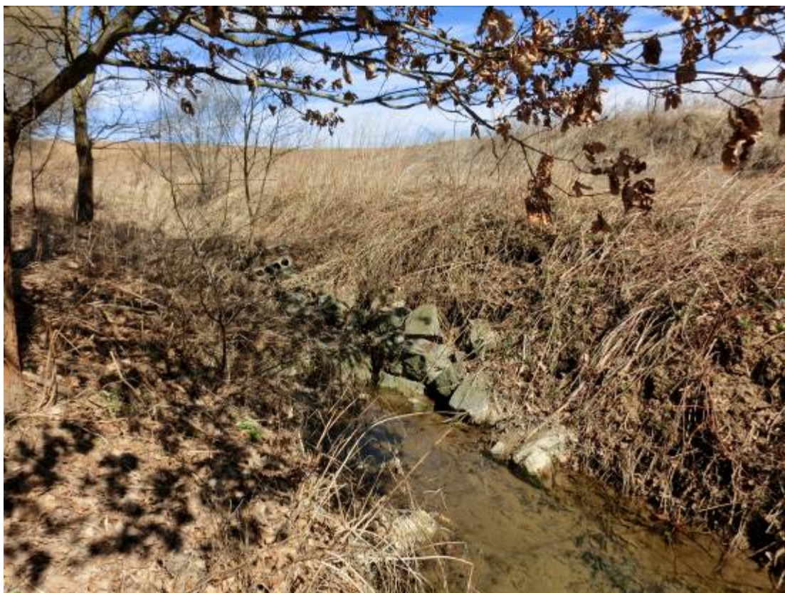
Obr. 26: Zbytky kamenného mostku
