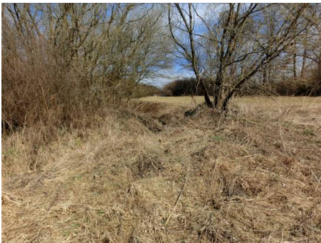
Obr. 27: Základy dalšího mostu o cca 40 metrů níže
