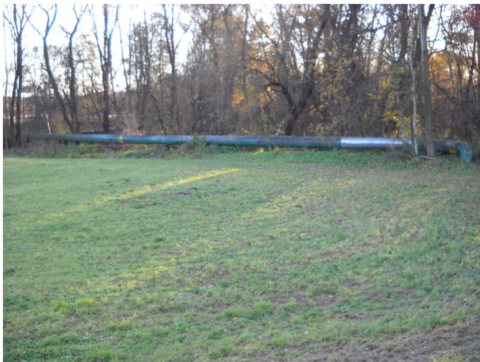
Plynovod vedený po povrchu v obci Stonava (I. Siudová, 30. 10. 2010)
