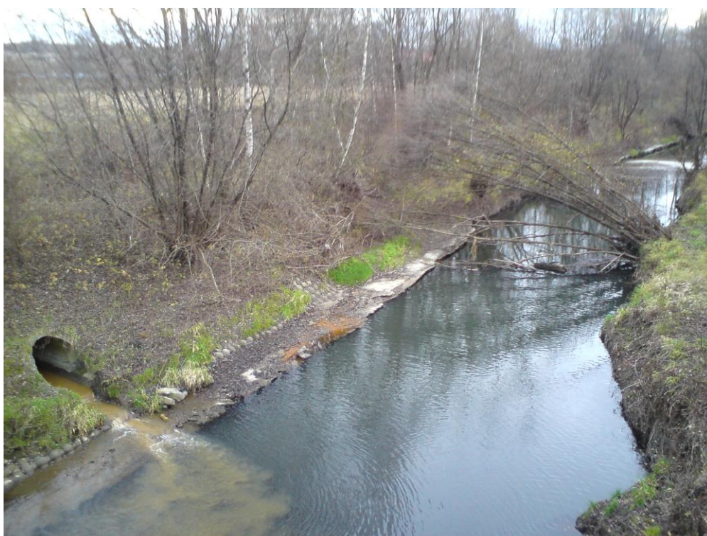
Upravený břeh včetně potrubí v blízkosti Dolu Darkov (I. Siudová, 13. 11. 2010)
