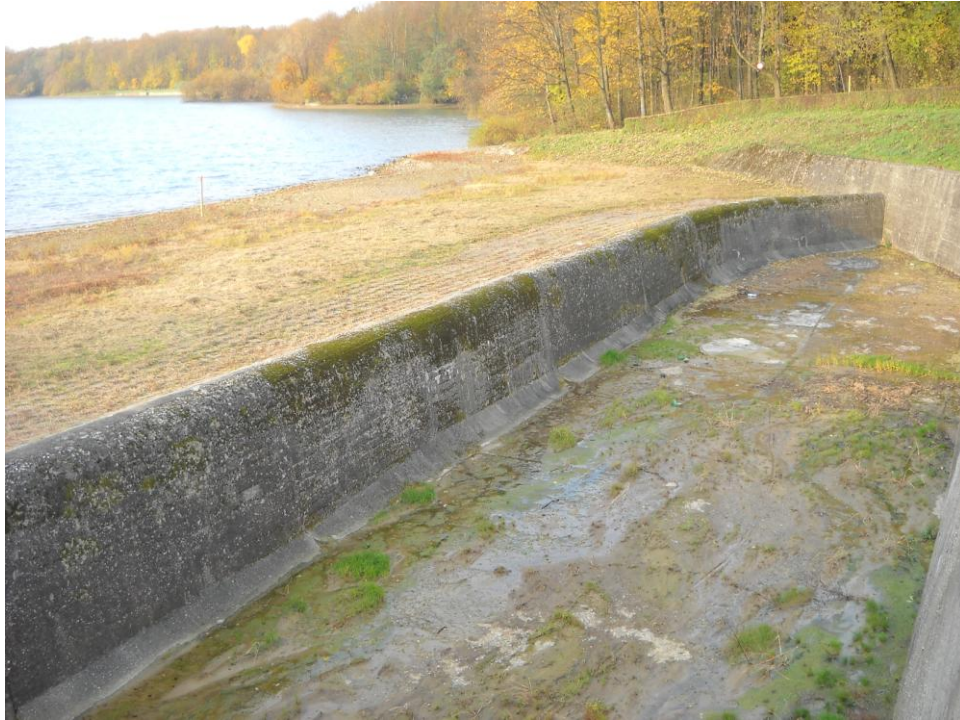
Přelivná hrana VD Těrlicko za běžného provozu (I. Siudová, 24. 10. 2010)
