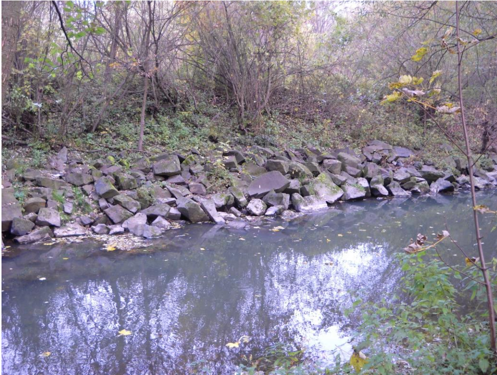
Zpevnění břehů pomocí kamenů v obci Albrechtice (I. Siudová, 24. 10. 2010)
