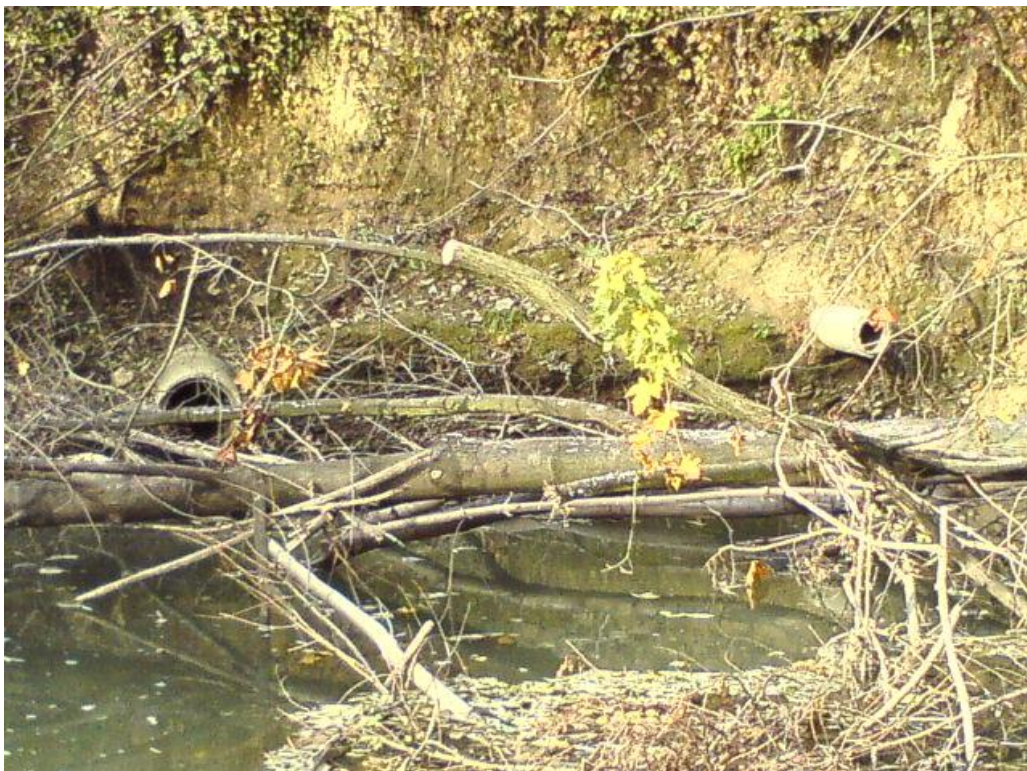
Potrubí, které se již dále nevyužívá, v obci Albrechtice (I. Siudová, 24. 10. 2010)
