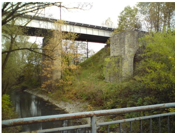
Obr. 9 Železniční most v Albrechticích (I. Siudová, 24. 10. 2010)
