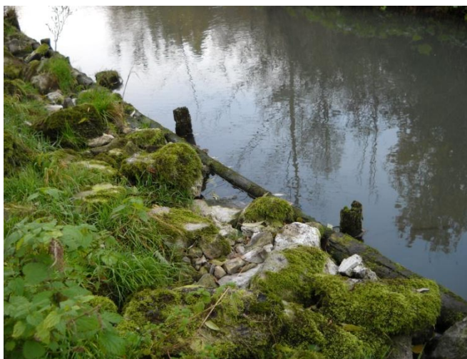
Obr. 8 Dřevěné kůly pod vodním dílem Těrlicko (I. Siudová, 24. 10. 2010)
