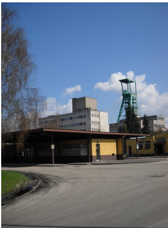
Obr. 1 Objekt Dolu ČSM (I. Siudová, 3. 4. 2010)
