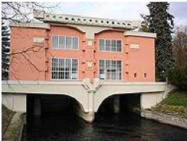
Obr. č. 11: Vodní elektrárna K. Plháka
