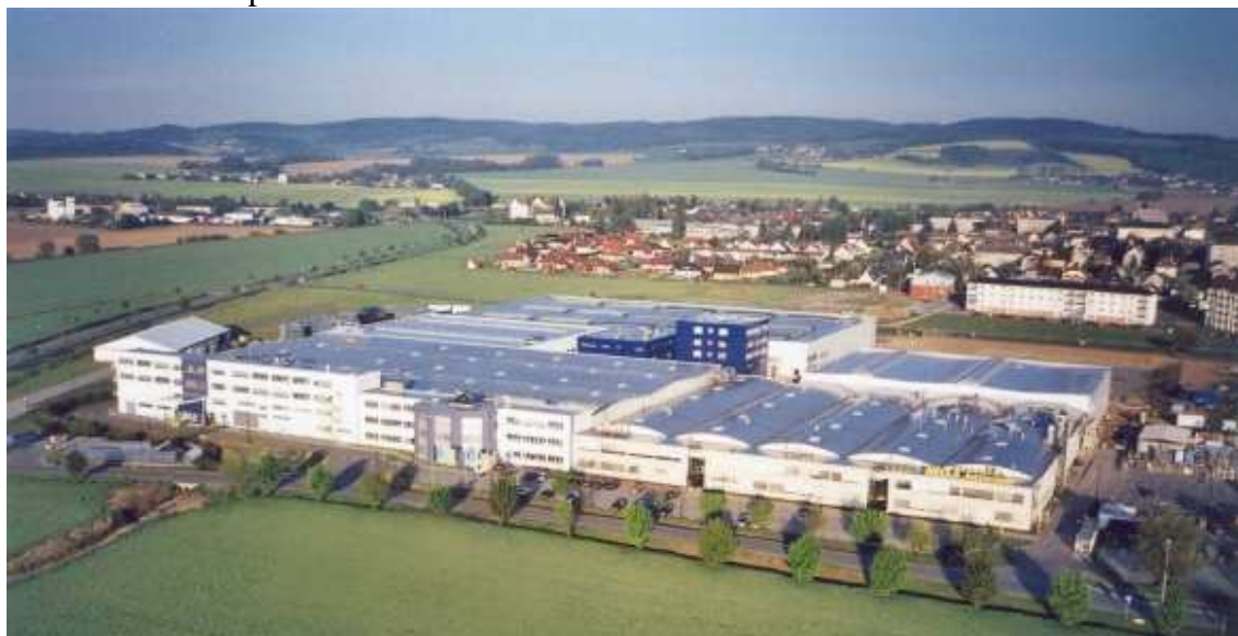
Obr. č. 3: Areál společnosti Hella Autotechnik s.r.o. v Mohelnici
