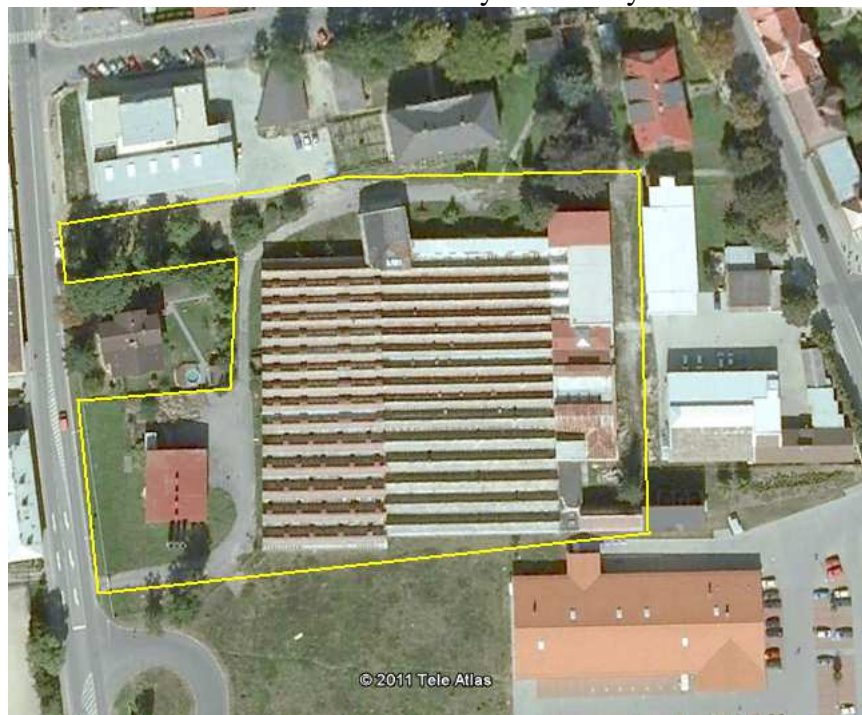
Obr. č. 13: Areál bývalé Hedvy
