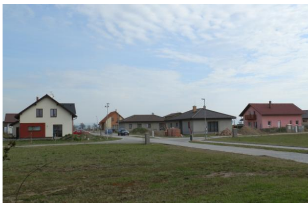
Obr. 27: Výstavba nových domů v Opočně v ulici Nádražní
