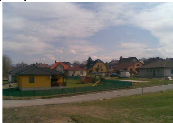
Obr. 28: Výstavba nových domů na jihozápadě Solnice
