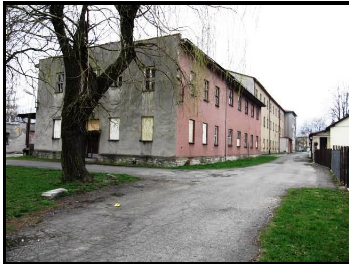
Obr. č. 39: Areál Bumbalovy továrny
