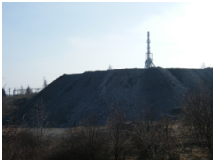
Obr. 31 Halda R 1 s těžní věží dolu Rožná 1 (zdroj: Svoboda 2011)
