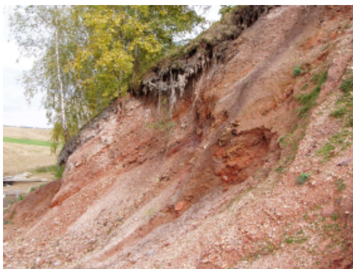
Obr. 2 Lokální sesuv na západním svahu haldy Kukla (zdroj: Svoboda 2010)
