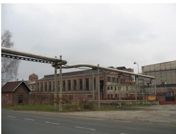
Obr. 15: Elektrárna Oslavany, pohled z jižní strany (foto Hana Staňková, 2010)
