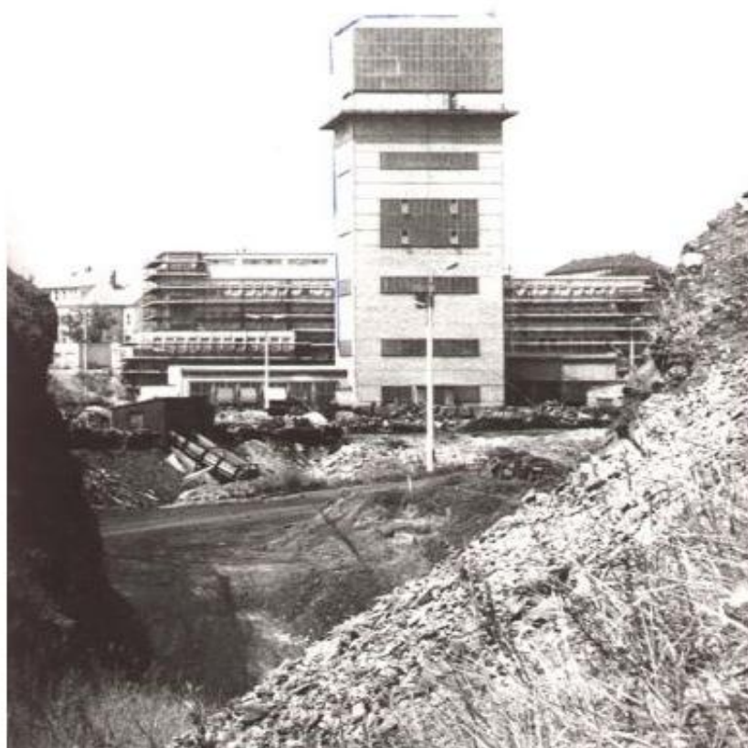
Důl Jindřich II ve výstavbě, Zbýšov, 1965, (zdroj: www.rosicko-oslavansko.cz )
