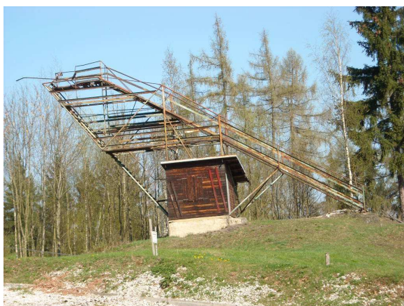
Obr. 7: zbytek skokanského můstku (foto: T. Slezák, 20. 8. 2010)
