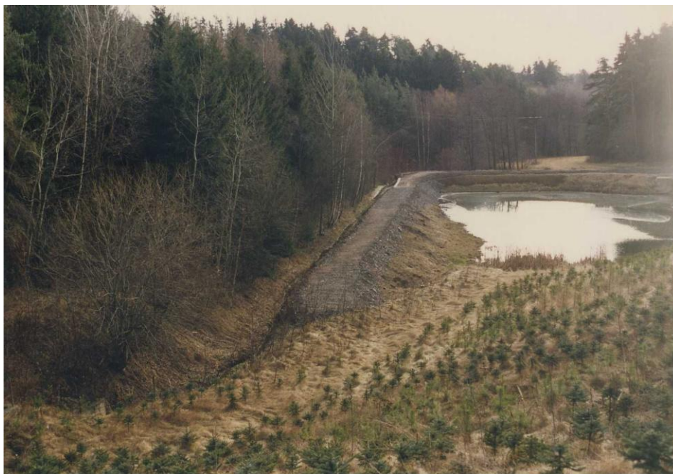
Foto 11: Úprava hrází akumulční nádrže pod odvalem Olší (únor 1998, archiv s. p. DIAMO)
