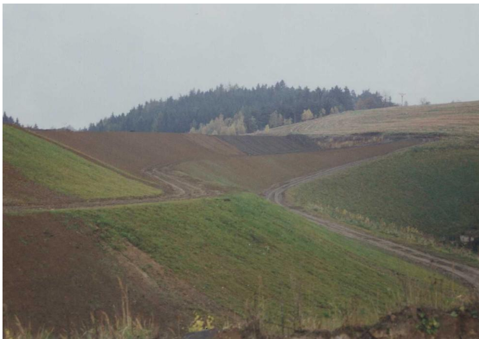
Foto 7: Jihovýchodní svahy odvalu Olší před zalesněním (1996, archiv s. p. DIAMO)
